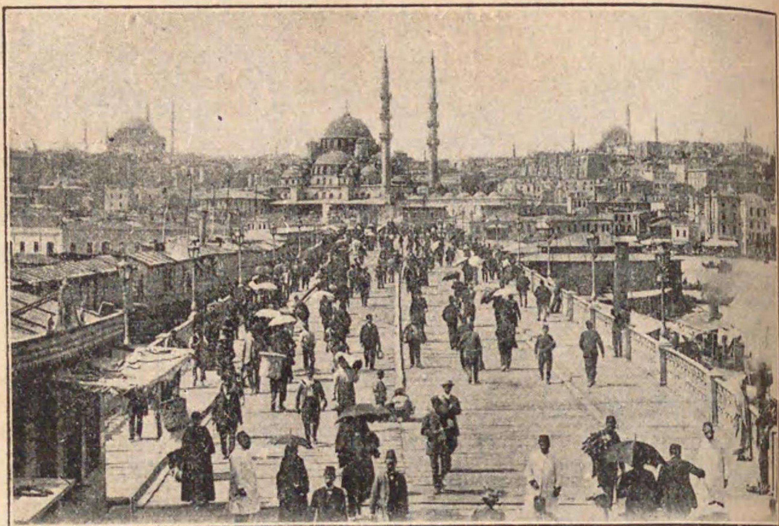
橋のタラが京土
