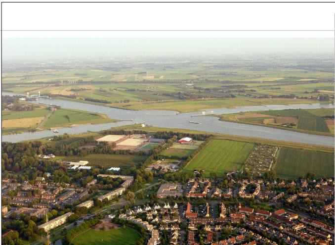
Het kruispunt van het Amsterdam-Rijnkanaal met de rivier de Lek. In verband met de sterke stroming op de Lek zijn verbredingen toegepast bij de mondingen van het kanaal.
