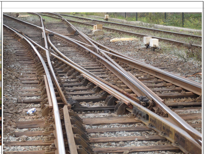
Een Engels wissel heeft de zelfde functionaliteiten als een kruispunt: het maakt zowel het kruisen als het afslaan van het verkeer mogelijk.
