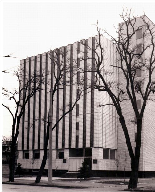
Фасад будівлі колишнього партійного архіву Одеського обкому Компартії України, 2015 р.
