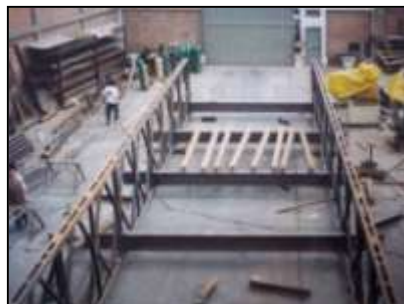
Montaje de Vigas Alma Llena en Cayumba Tingo María y Puente Reticulado en San Isidro - Ica
