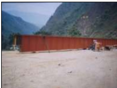
Montaje de Vigas Alma Llena en Cayumba Tingo María y Puente Reticulado en San Isidro - Ica
