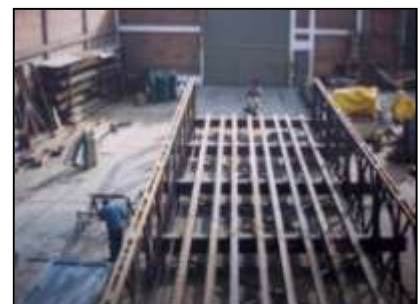
Montaje de Vigas Alma Llena en Cayumba Tingo María y Puente Reticulado en San Isidro - Ica
