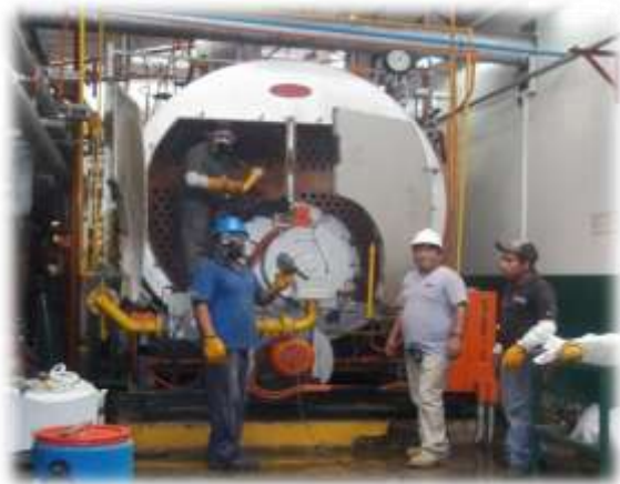
Caldero 800 BHP – Espalda Húmeda
