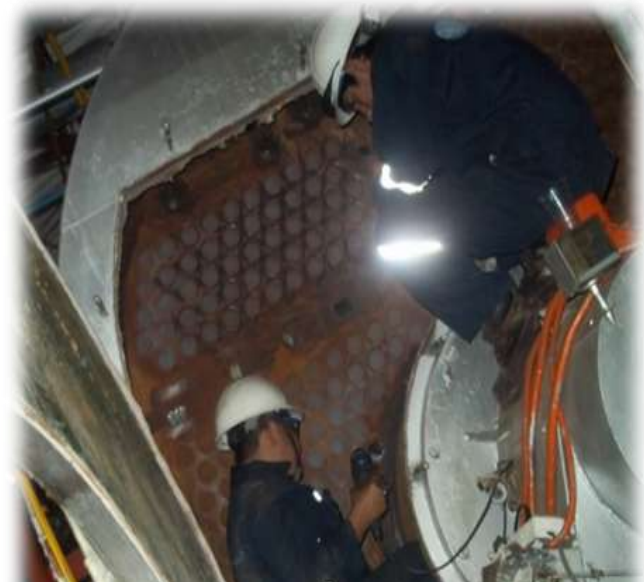
Caldero 800 BHP – Espalda Húmeda
