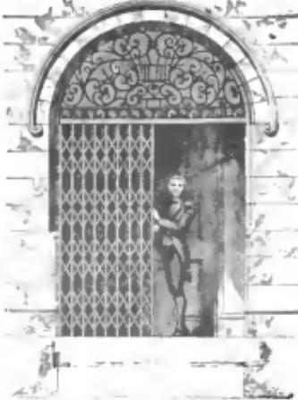
Die Schrägstäbe sind mit den Senkrechttäben und eingesetzten Futterböden, welche zur Fütterung der Scheren innerlich der Leisen dienen, beweglich vernietet.
