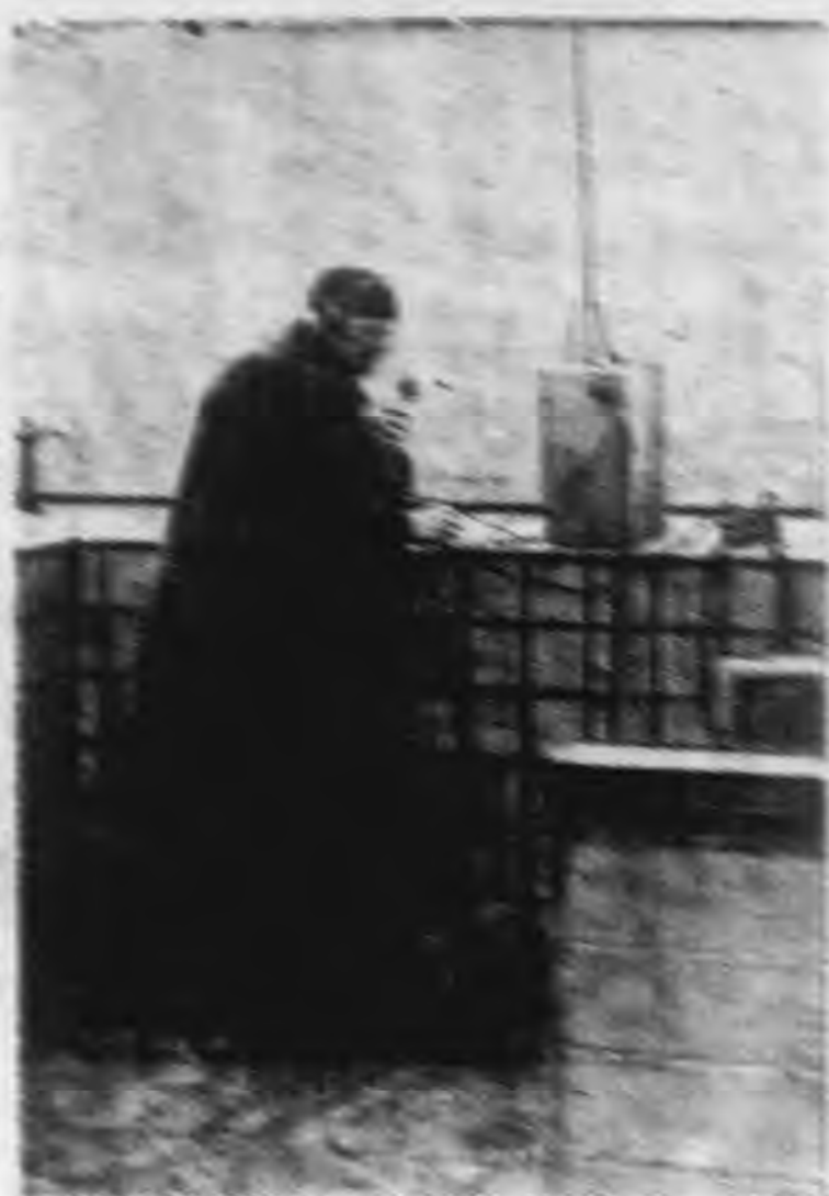
第八圖：守備台上之無線電裝置。
