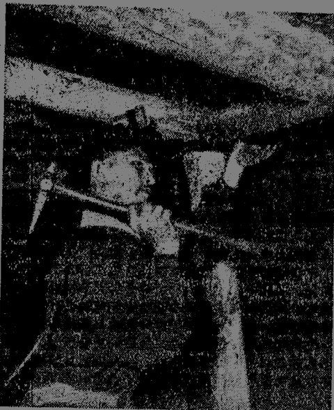
资兴矿务局北平煤矿安全科检查员、共产党员蒋仲坤，正在检查小巷的支护安全。(唐又超摄)
