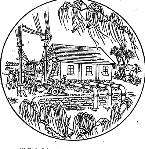
装修电力排灌站 黄耕排灌站
