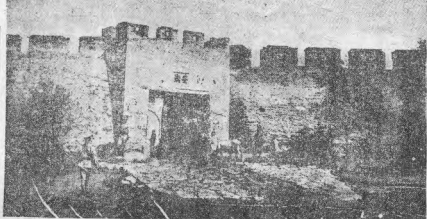
包頭鎮 西門外砲台遺址
