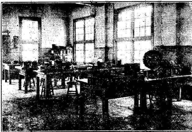
修理廠設備之二(圖八-2)
