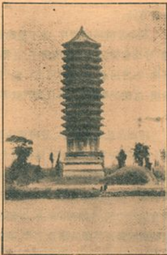
塔中的水塔（古代藝術對於現代需要上的一種聰明的運用）
