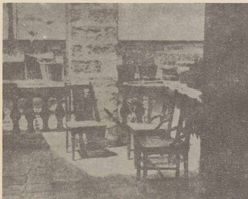
Azotea (terrace) of the house of the Rizals in Calamba (reconstructed) Azotea de la casa de los Rizal en Calamba (reconstruida)
