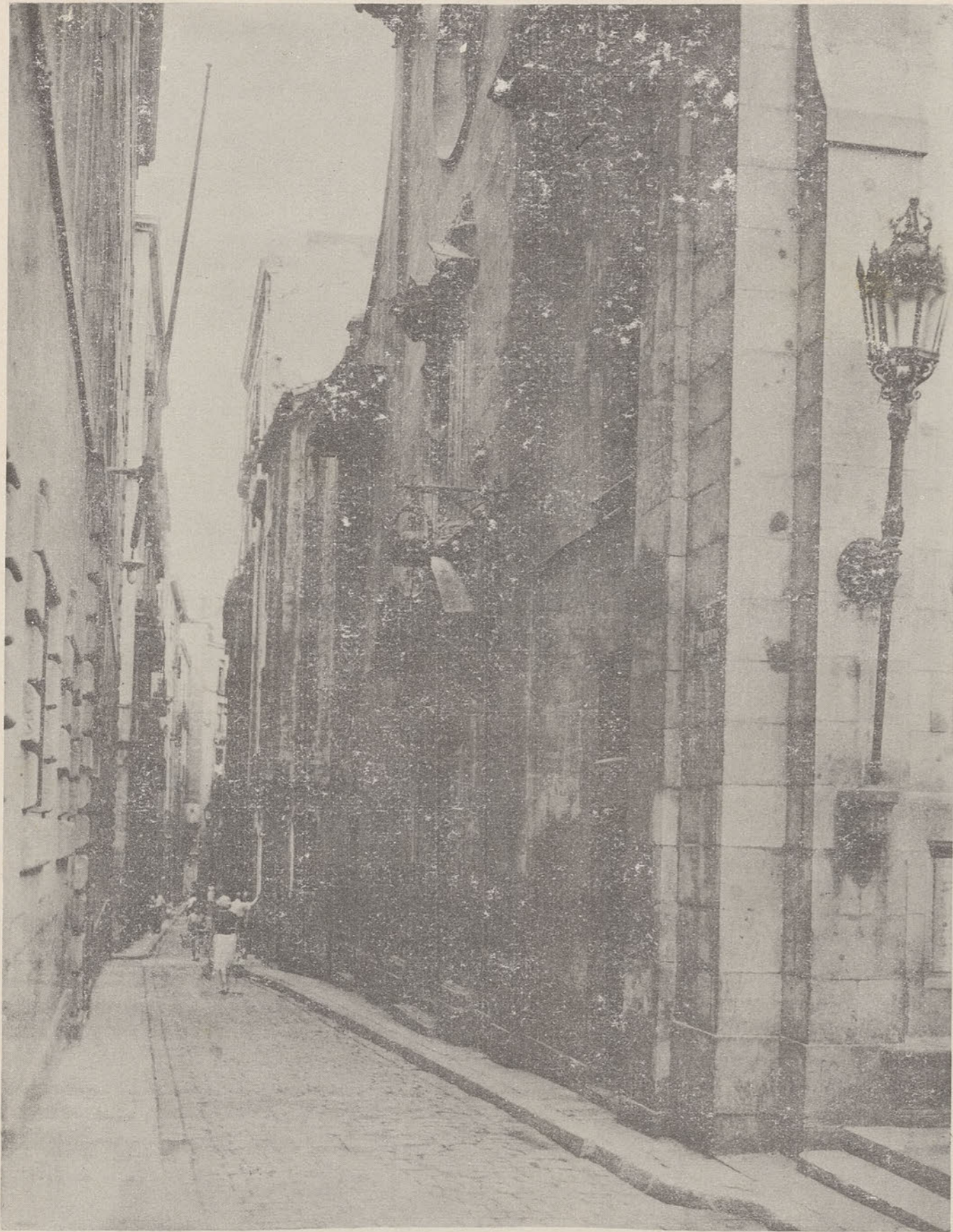
San Severo St. (a boarding house)—Rizal lived here in 1882 Calle de San Severo, Pension la Verdad. Rizal vivió aquí en 1882 O-020233-4
