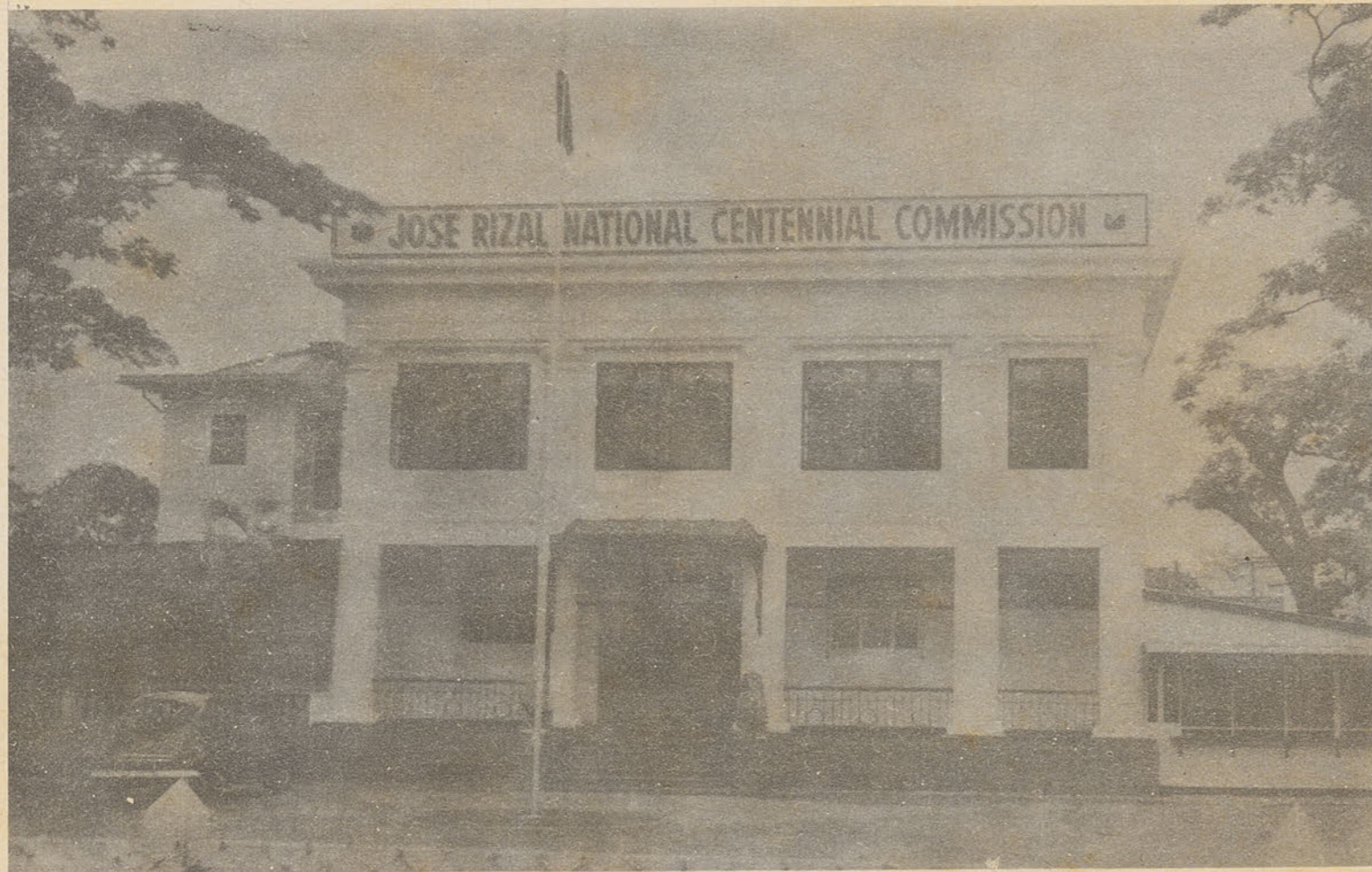
José Rizal National Centennial Commission Building, Manila Edificio de la Comisión Nacional del Centenario de José Rizal, Manila
