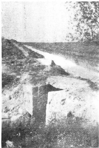
圖十：萬全第一渠及其放水處，右岸以地面高於水面，很難加以利用。
