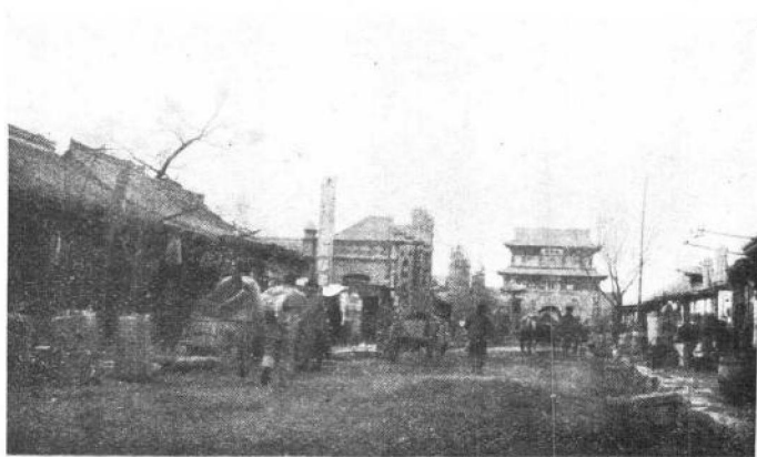
圖二十六：宣化城內。北爲鎮朝樓，比較熱鬧。
