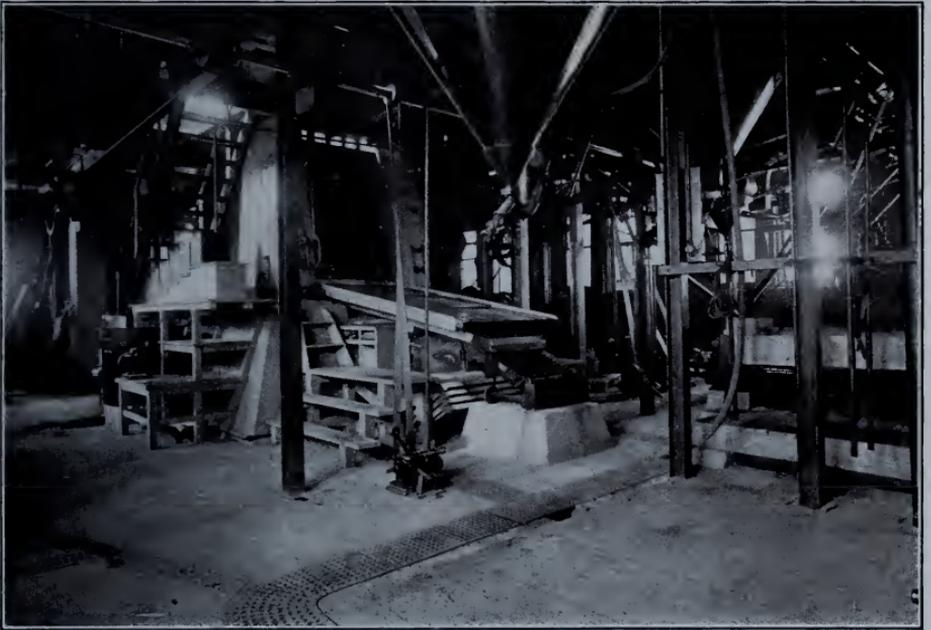
Laboratoire de la préparation du minerai; 1er étage: réservoirs Callow, batterie de bocard, boîtes à cyanuration en zinc.
