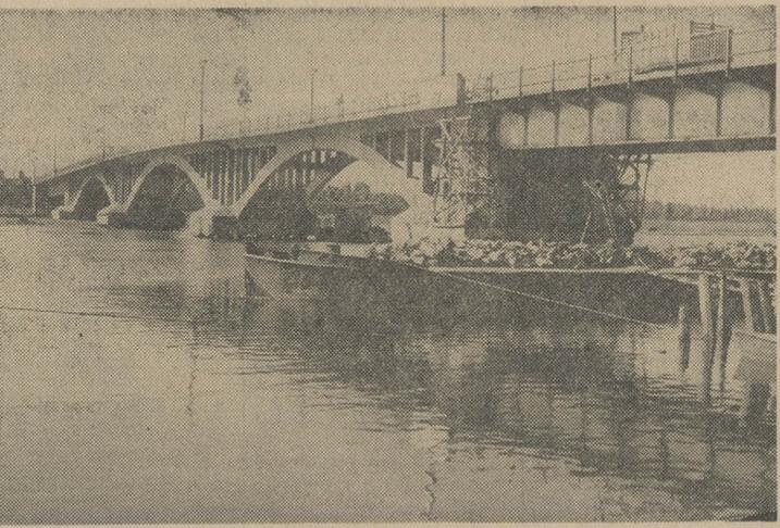
پل متحرک بندر پهلوی ، هنگام رفت و آمد کشتیها بالای آید تا کشتیها از زیر آن بگذرند
