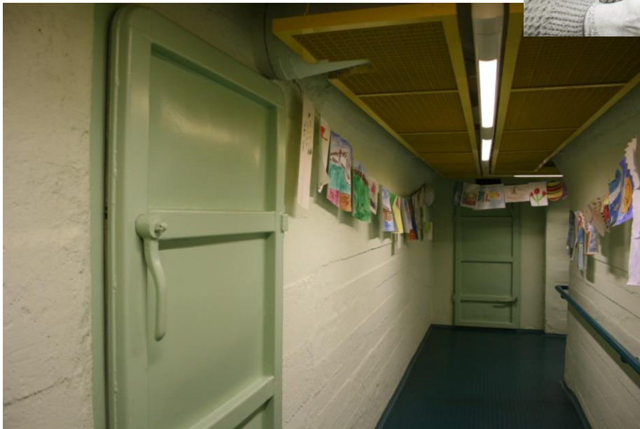
Podzemní část nemocnice Krč, CC-BY-SA 3.0
