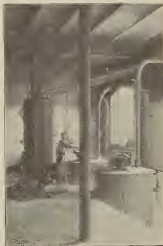
FERROCARRIL FUNICULAR DEL TIBIDABO. — Generadores de gas Dawson
