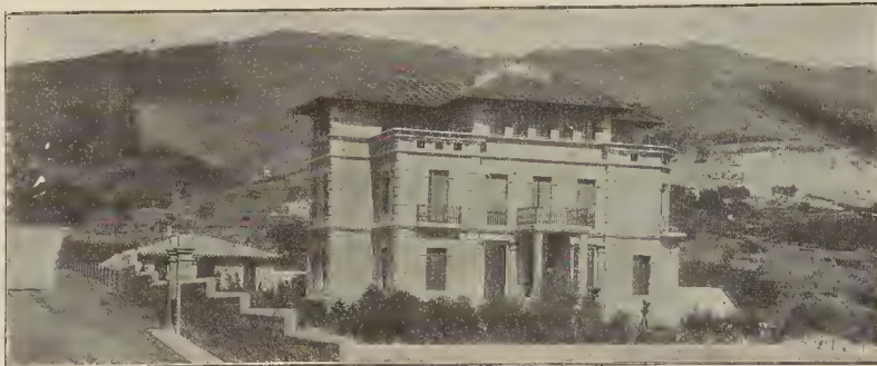
Vista general del edificio construído en Sarrriá por suscripción pública y dedicado por la ciudad de Barcelona á Ríus y Taulet
