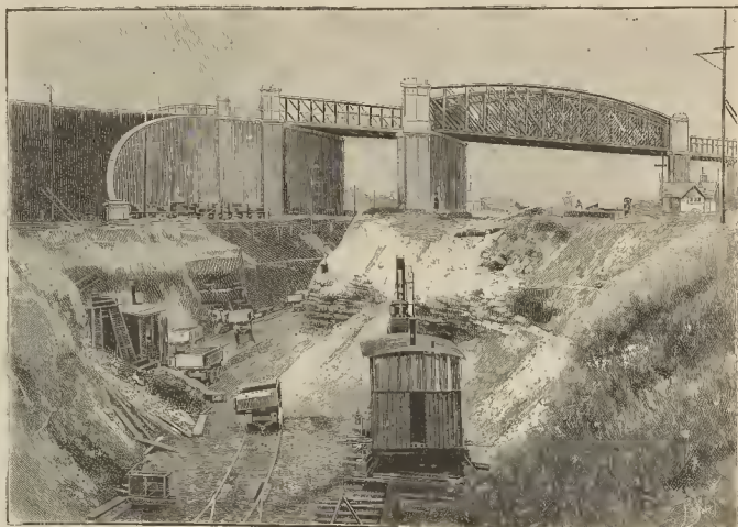
Fig. 2. - Máquinas para abrir trincheras empleadas en los trabajos del canal de navegación de Manchéster
