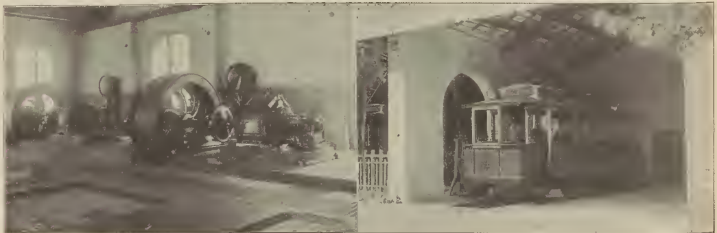
FERROCARRIL FUNICULAR DEL TIBIDABO. — Vista de los motores y dinamos con el grupo elevador y cuadro de distribución de la central. — Carruaje del tranvía en su cochera
