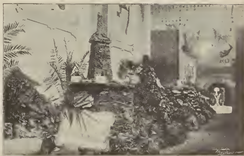
INSTALACIÓN DE FIZARRAS BITUMINOSAS DE LA CUENCA DE BASTARENY (BARCELONA)
