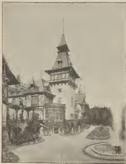
Vista de la fachada Oeste del Castillo Pelesch, residencia de Carmen Sylva
