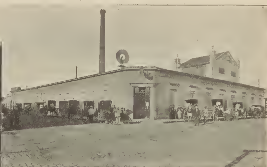
REPÚBLICA ARGENTINA. - BUENOS AIRES. LA MARTONA. VISTA GENERAL DEL DEPÓSITO CENTRAL (de fotografía de H. G. Olds, de Buenos Aires)
