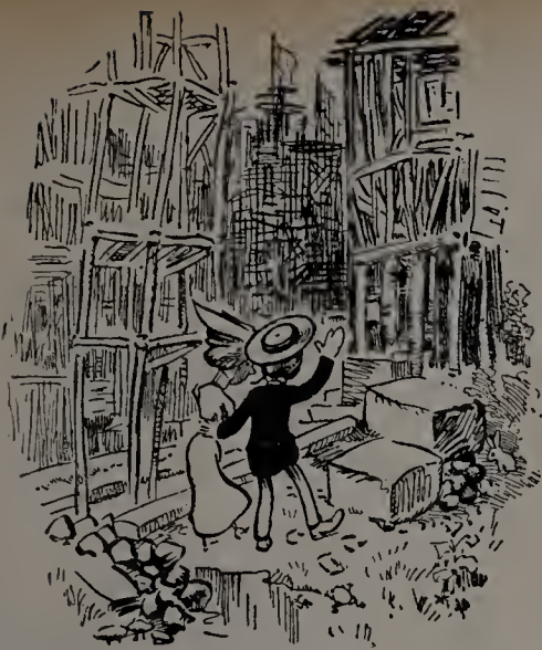
LES TRAVAUX DE DÉMOLITION DE LA DÉPUNTE EXPOSITION SE POURSUIVENT AVEC UNE FÉBRILE ACTIVITÉ
