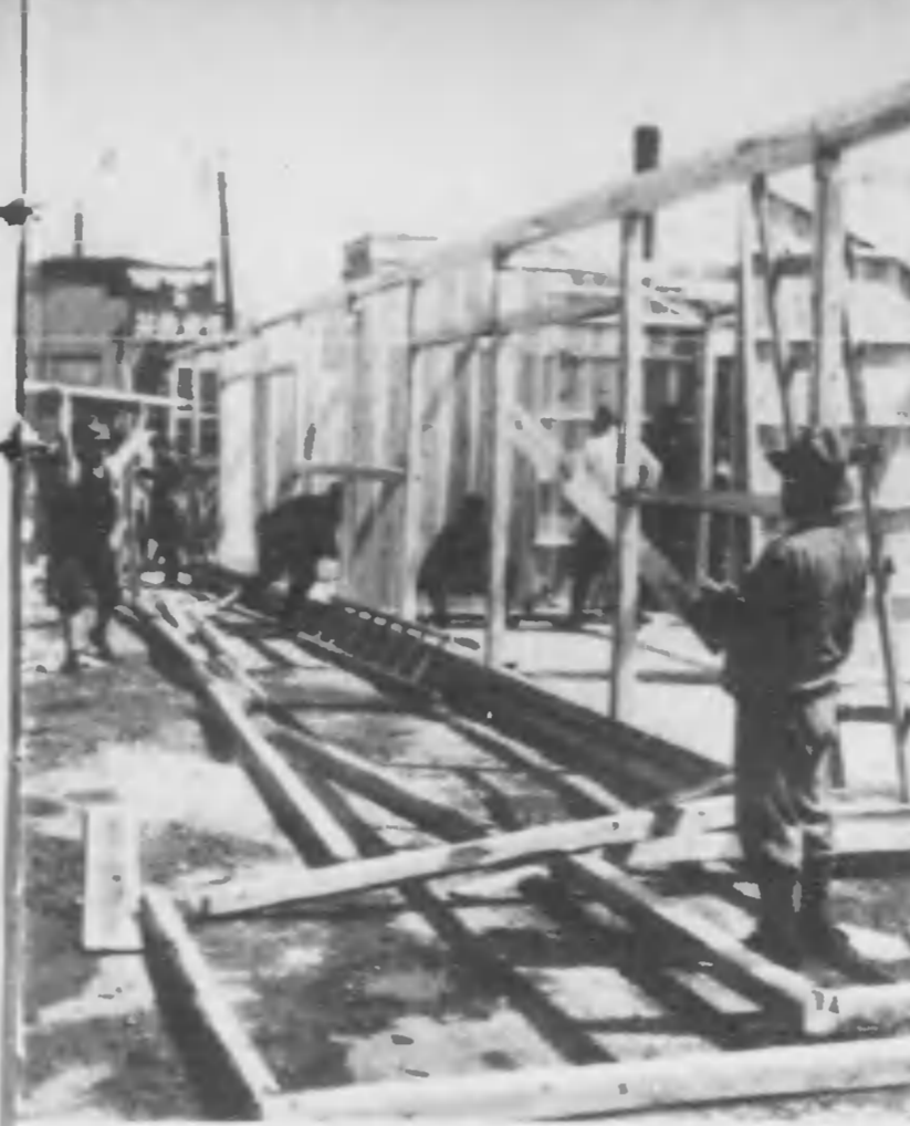
○戦時らしい浦田がすつり倉庫に積まれてゐる。○の銘が入つた救急物資の一つ 救急物資の救急物資の救急物資は、當局指示の要綱によつて各地にそれ／＼準備さ れてゐる。浦田市(町)長の指令によつて建設部が助成すれば、あらかじめ切 りこまれた材料は、一棟四戸建の建物に僅々一時間の速さで建てられる
