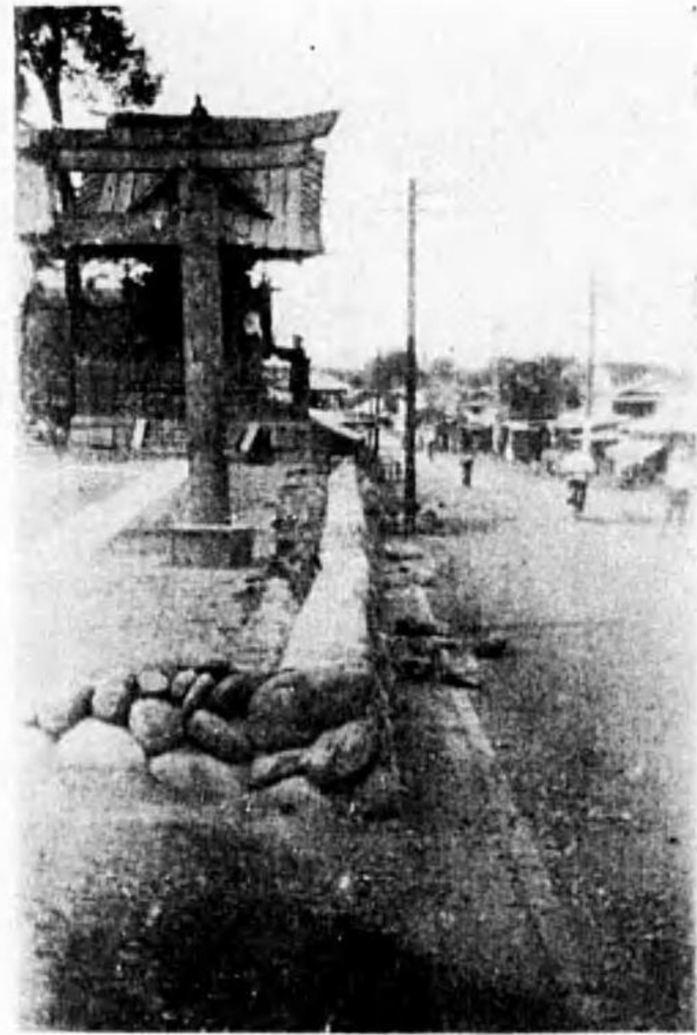
第五十五圖 比企郡松山町本町八雲神社東側石垣の破損
