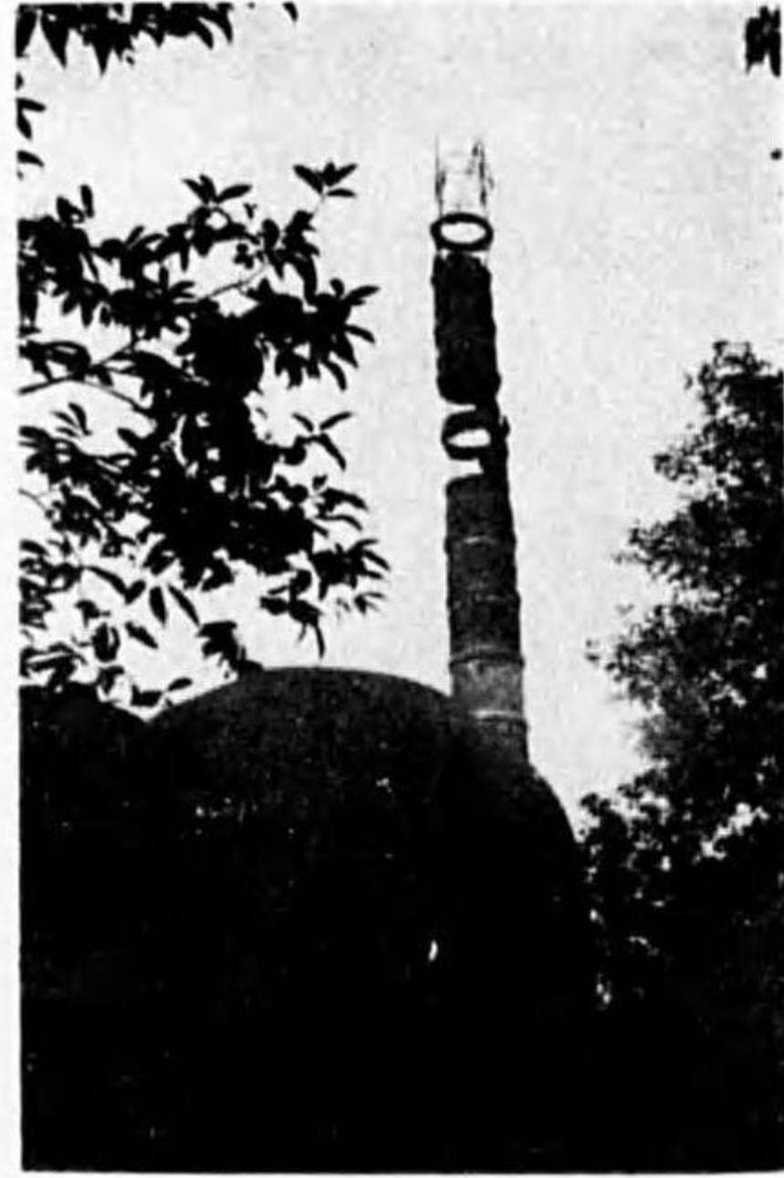
第五十九圖 深谷町大字大沼煙突の破損
