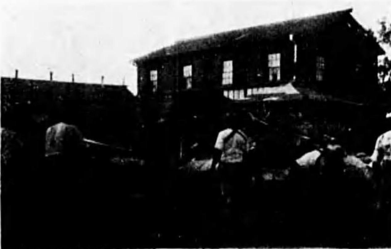
潰倒の庫倉社合粉製本松區原石町谷熊
