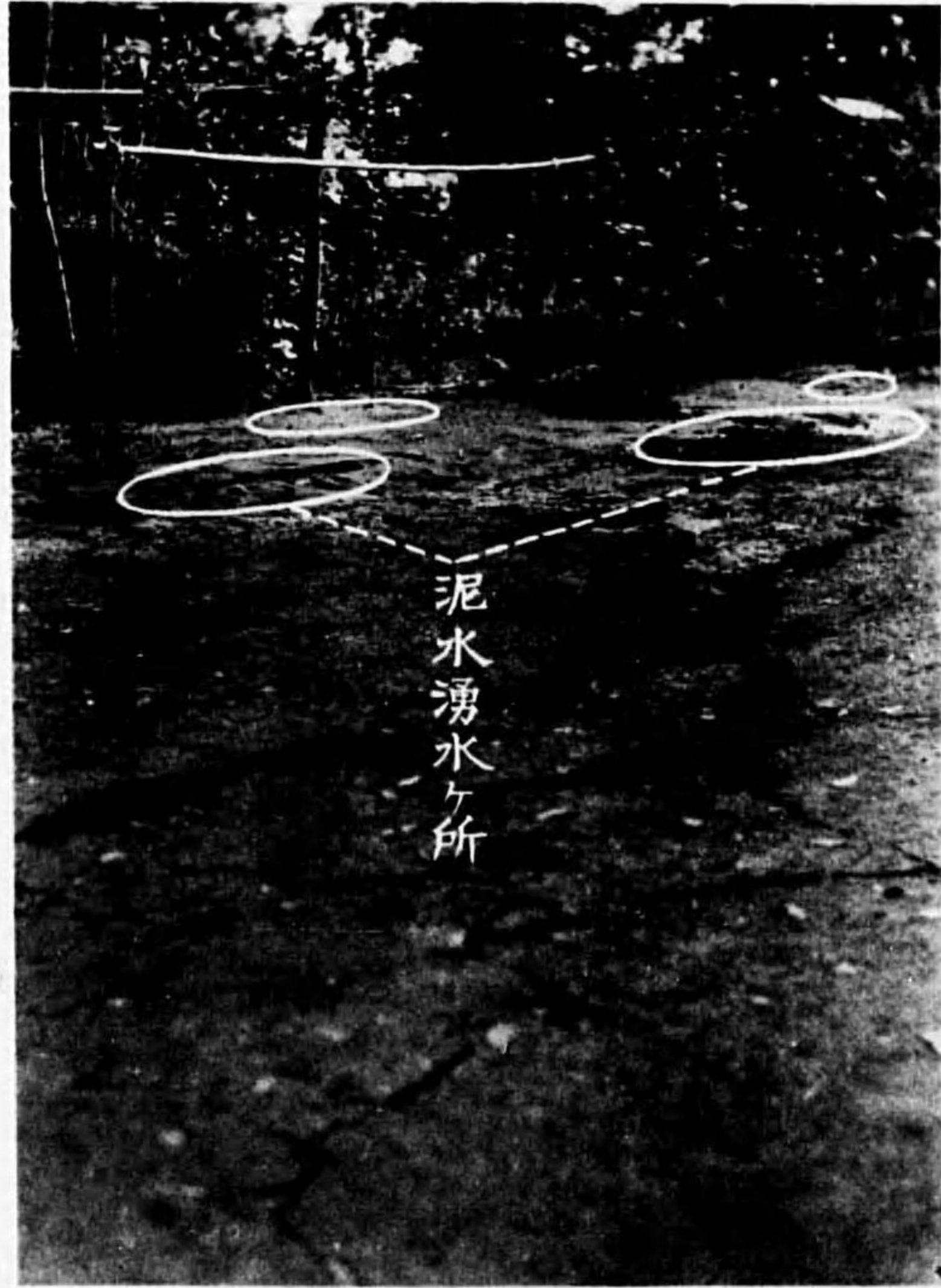
第十六圖 吹上村東曜寺境内の龜裂(北東—南西) (南西より撮影)
