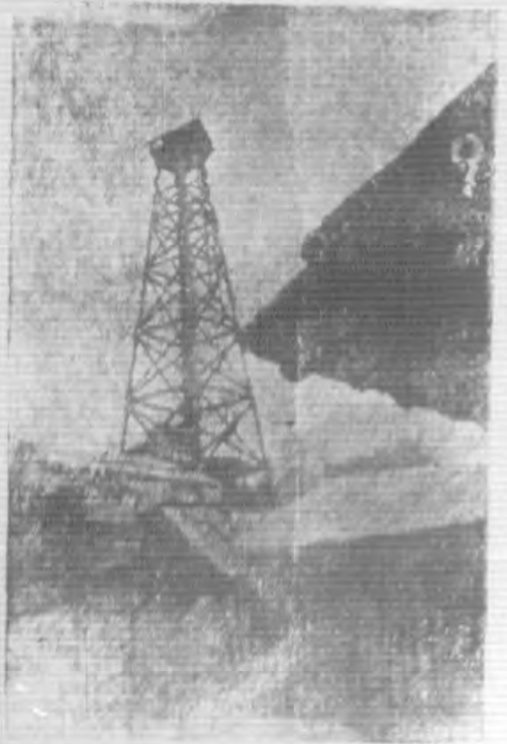
老 井 之 抽 油 台
