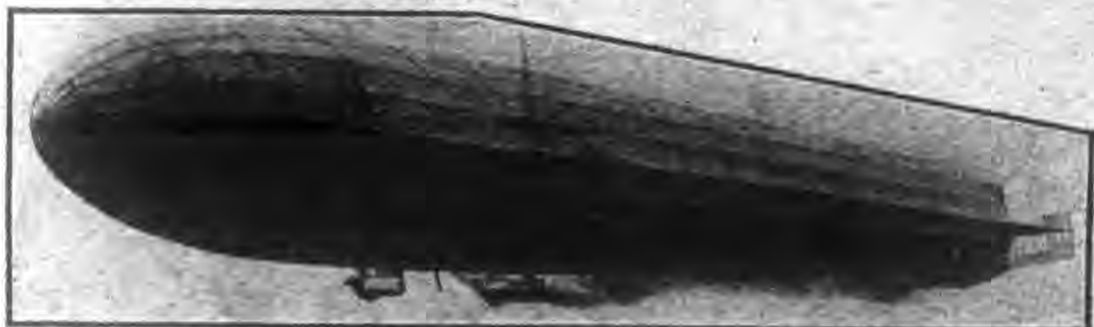
圖為徐伯林第五十二號之攝影體長五百二十英尺徑五十三英尺又七英寸外罩內有氣球十八共含輕氣二萬七千方米突價五萬鎊
