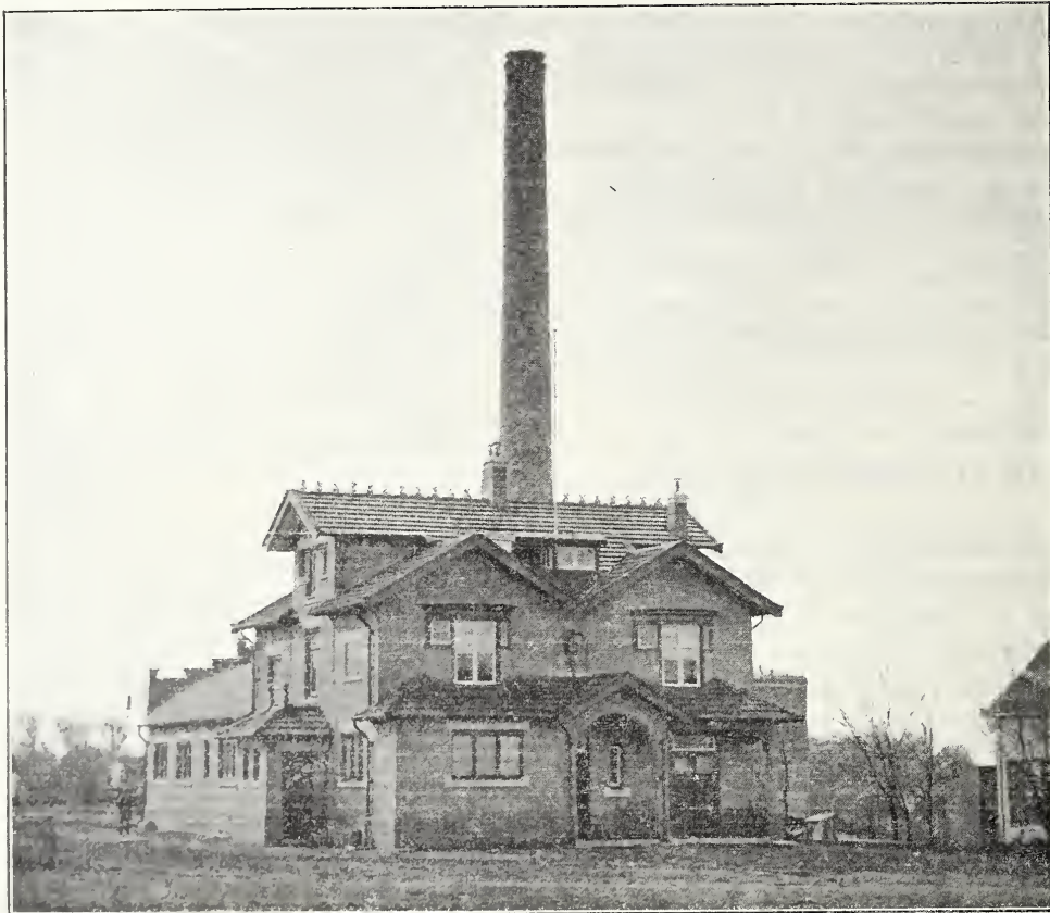
Centraalstation voor Electriche Stroomlevering te Hilversum. Architect A. SALM G.Bzn.
