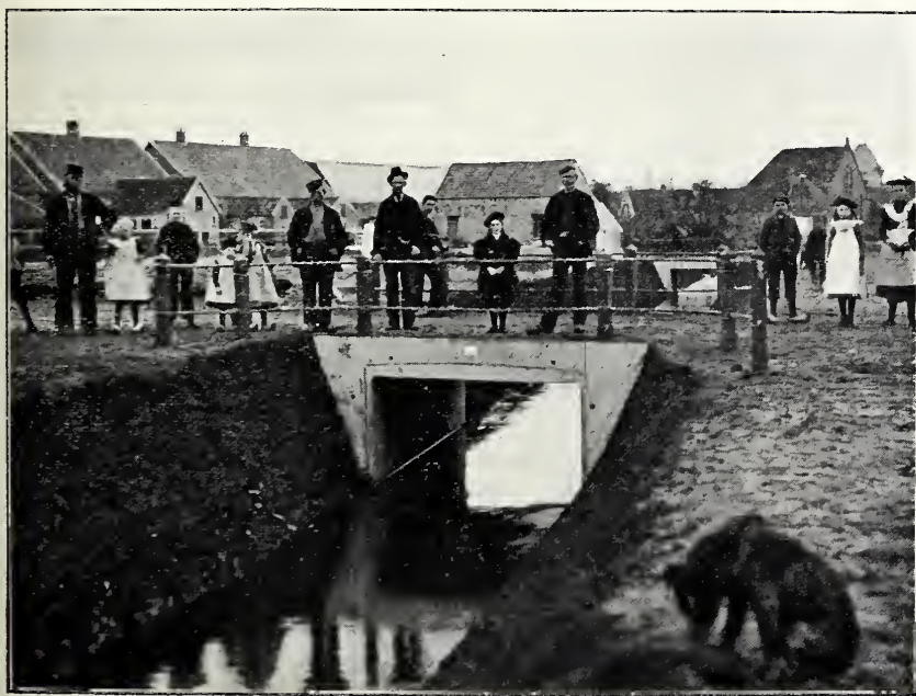
Twee duikers voor de Erven EKKER te Hengelo in de Diemerbeek, elk lang 6 M., breed 2.25 M., hoog 1.50 M., bestand tegen raddrukken van 3000 KG.
