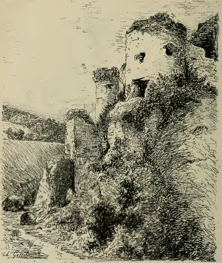
GOSSELIN (C.). H. C. Château d'Arques. — Château of Arques.
