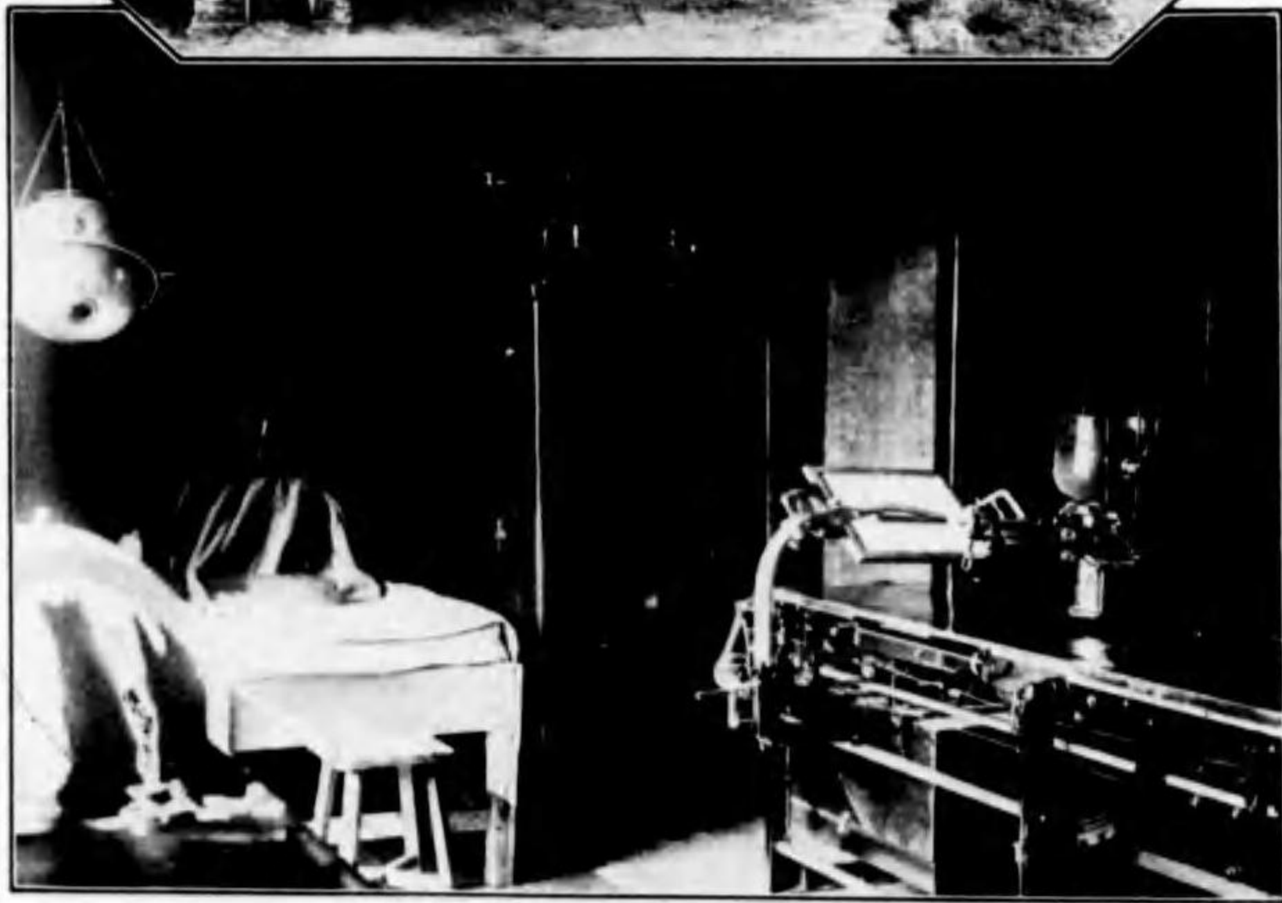
(レントゲン室)
