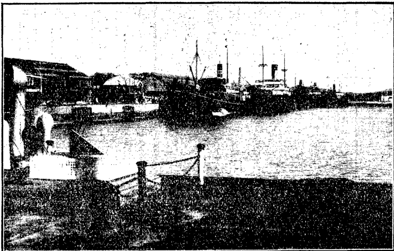
仁川港船渠內面觀
