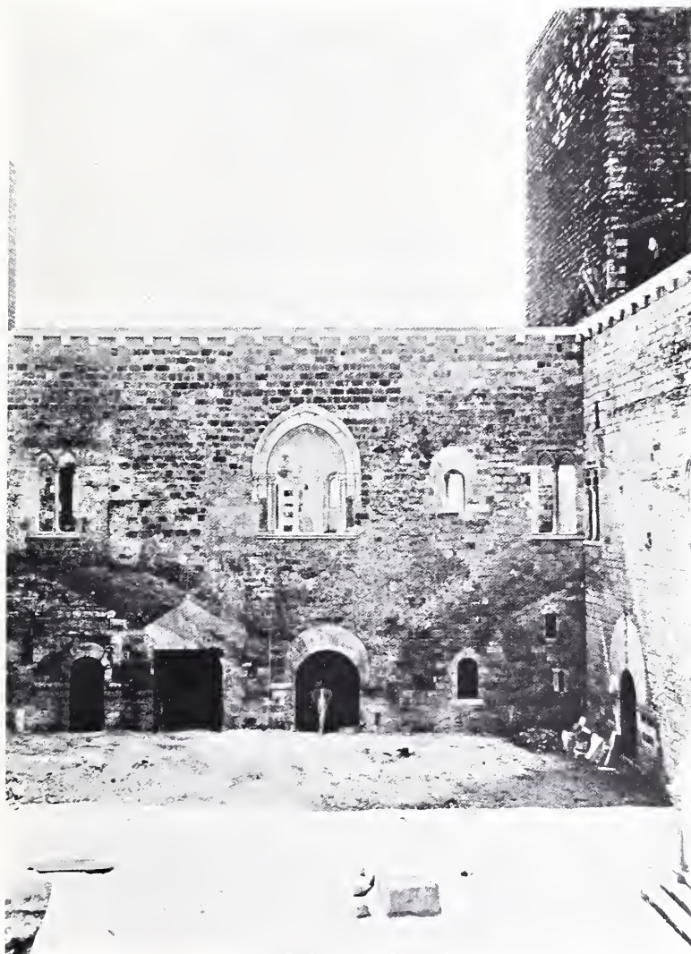
Abb. 7. Gioia del Colle. Die Südwand, Hofseite
