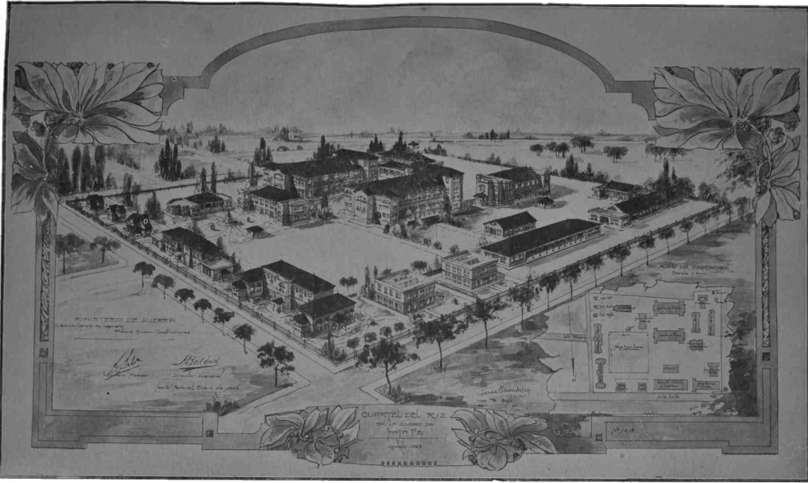
Vista de conjunto del Cuartel de Infantería en construcción en la Ciudad de Santa Fe.
