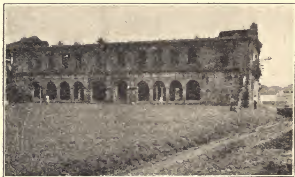
Portobelo: Ruinas del edificio de la Aduana.
