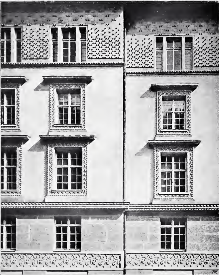
K. k. Amtsgebäude, Wien, I. Riemergasse 7. Vom Architekten Alfred Keller.
