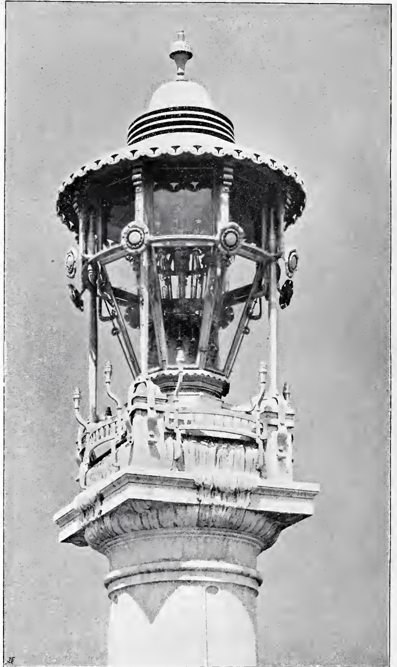
Beleuchtungskörper an der Radetzkybrücke in Wien. Von den Architekten Oberbaurat F. Ohmann und Josef Hackhofer.
