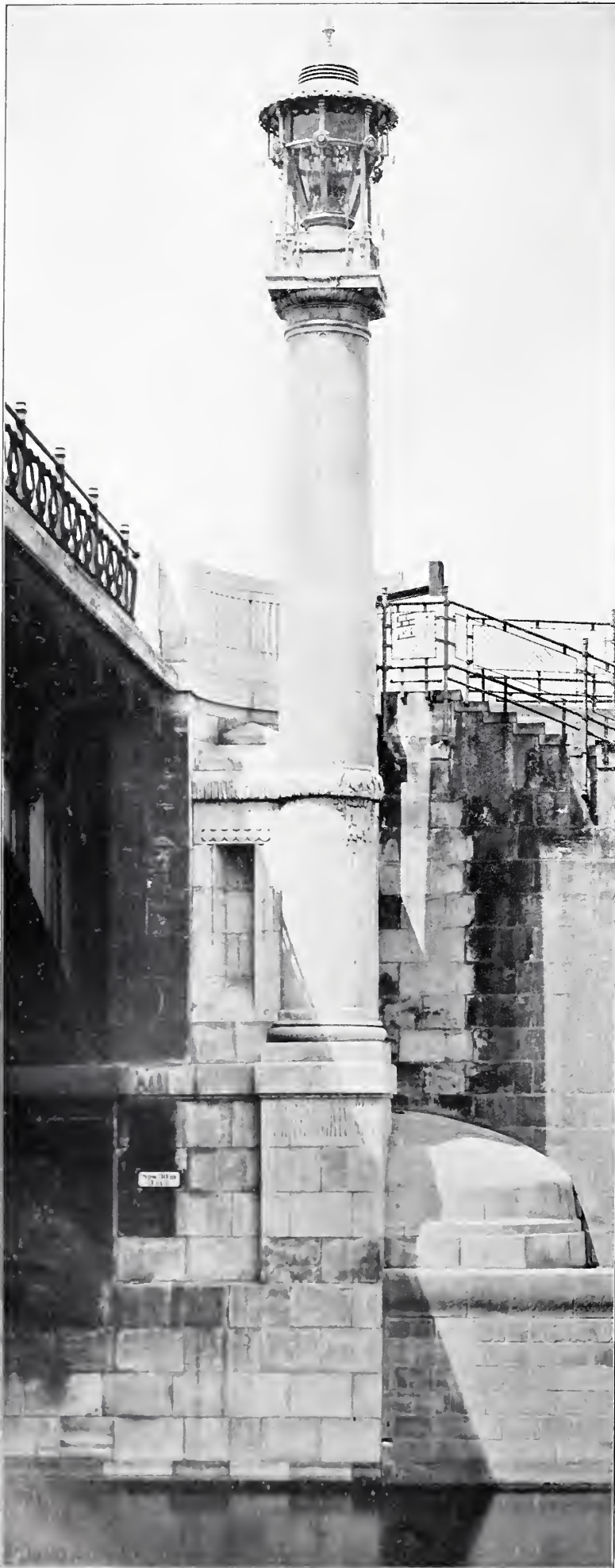
Beleuchtungskörper an der Radetzkybrücke in Wien. Von den Architekten Oberbaurat F. Ohmann und Josef Hackhofer.
