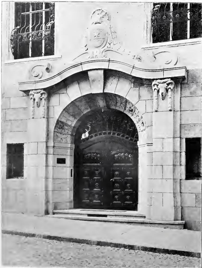
Hauptportal der neuen Sparkasse in Bozen. Bildhauer Kompatscher und Winder. Architekt Wilhelm Kürschner.
