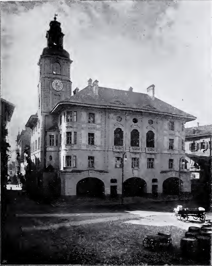
Das neue Rathaus in Bozen. Erbaut nach den Plänen von Prof. Karl Hocheder in München und Stadtarchitekten Wilhelm Kürschner in Bozen.
