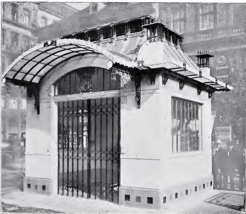
Wartehalle in Prag, Wenzelsplatz. Vom Architekten Meč. Petru. Ausgeführt von J. Vielwerth, Kunstschlosser.
