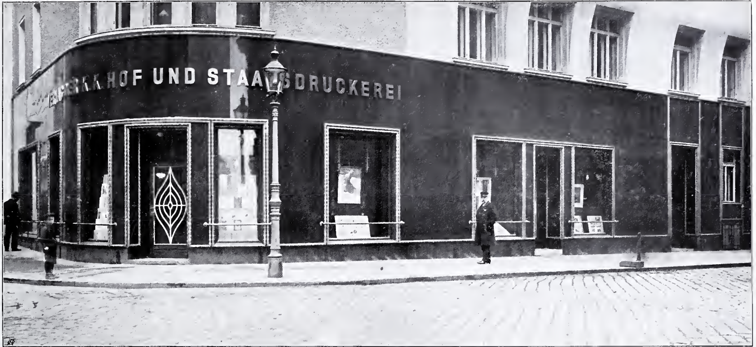
Portal des Verlages der k. k. Hof- und Staatsdruckerei in Wien, I. Seilerstätte. Vom Architekten k. k. Prof. Josef Hofmann. Material: Verkleidung in schwarzen Granitplatten, Umrahmung der Fenster und Türen in getriebenem Kupfer, vergoldet.
