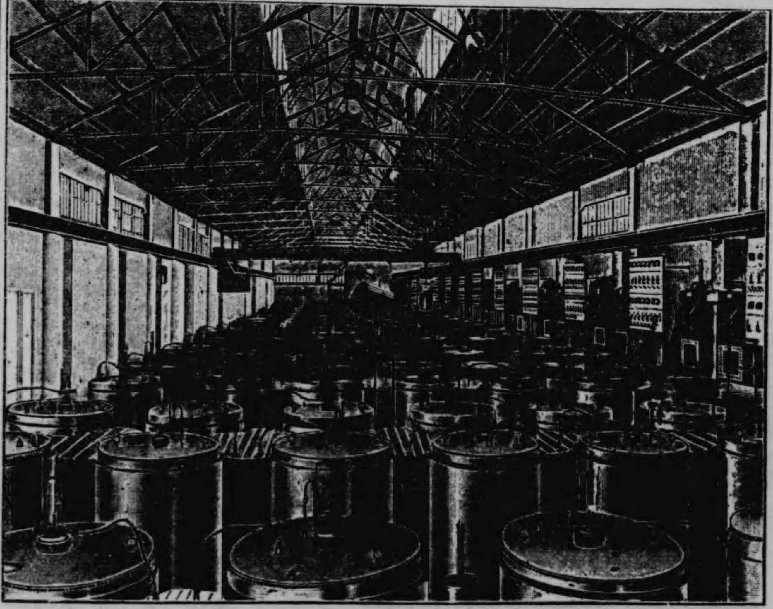
〔圖の部内場工社會素窒石灰石「ンータスウスーノ」在「タツオ」威諾〕 孔質とな さしめ、 窒素瓦斯 の流通を 充分なら しむる事 あり。吸 窒の模様 は瓦斯流 入管に設 けられた る特別の 壓力計に より知ら るゝ様に なしたり 吸収は實 際約三十 時間に及 びて完結 さるゝと 云ふ 我國に實 行せられ 居る方法
