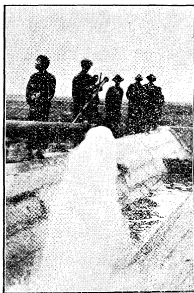
抽水機放水情形
