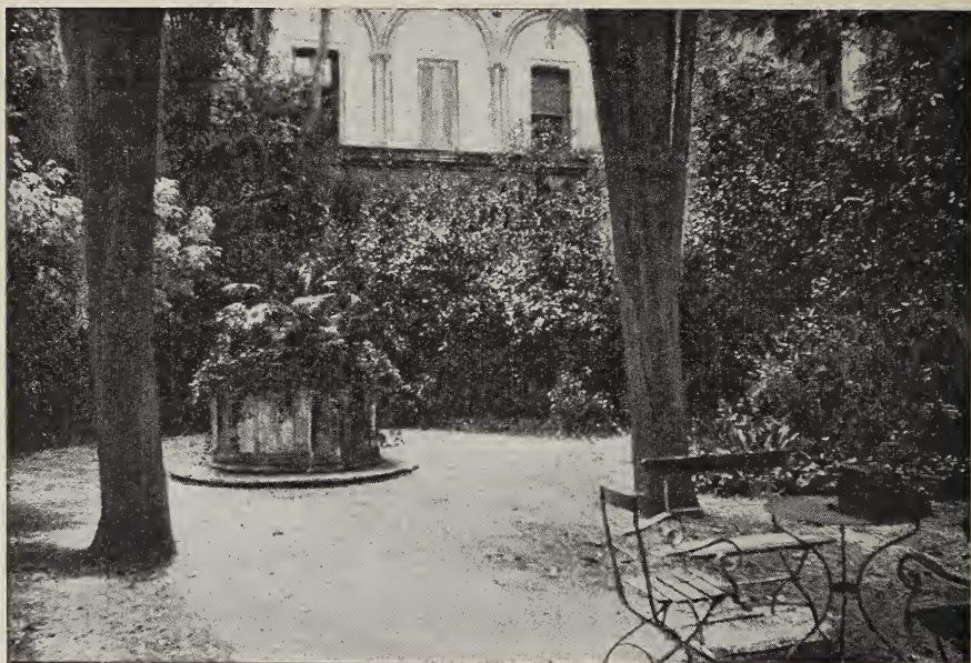
Cortile e cisterna.
