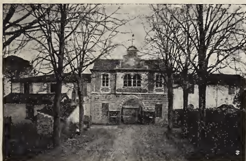
Fabbriche riunite di ceramica.
