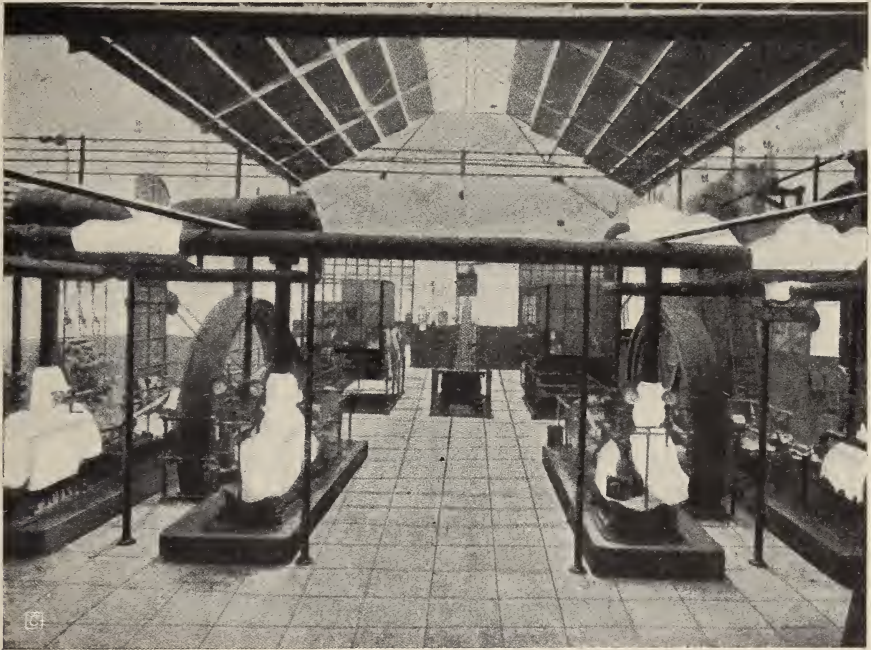
Sala delle macchine frigorifiche della « Società del ghiaccio artificiale » di Torino.
