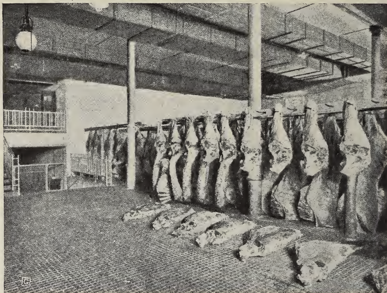
Anticamera dell'impianto frigorifico nel macello pubblico di St. Marx a Vienna.
