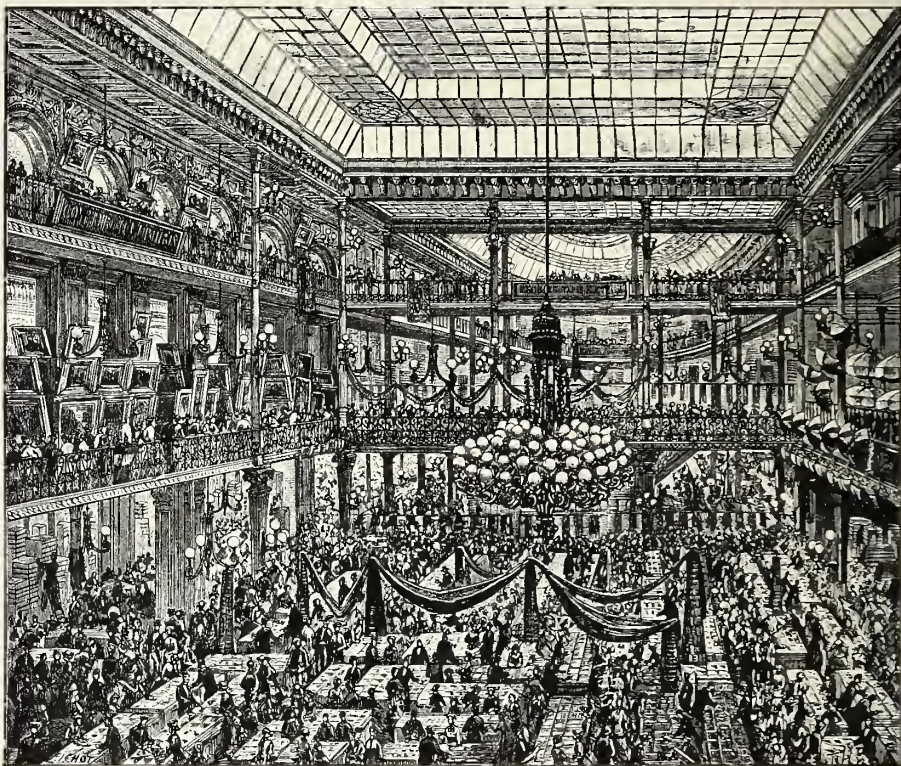
Fig. 411. — Intérieur des Grands Magasins du Bon Marché (à gauche, au premier étage, est la galerie de tableaux, avec cabinet de lecture).
