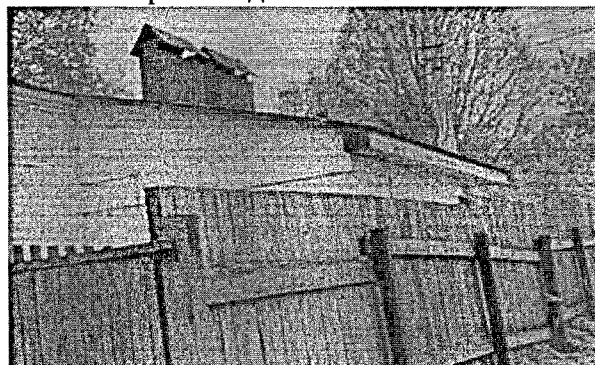
Объём котельной лит. А3
