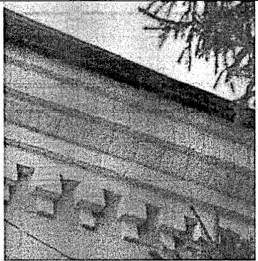
Кирпичный профилированный карниз со ступенчатыми сухариками
