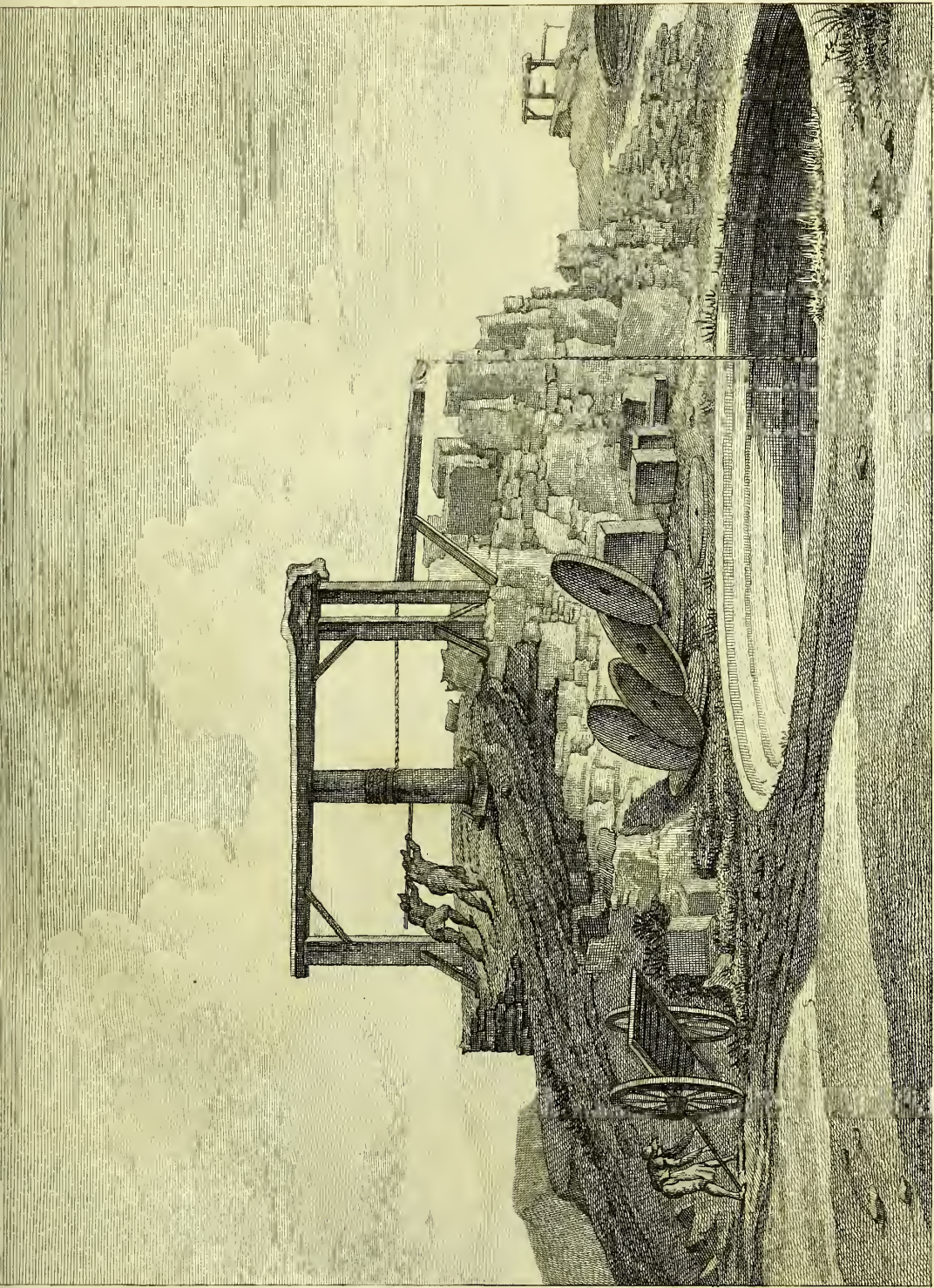
MANIERE d'enlever les MEULES de Moulin du fond des CARRIERES, dans les environs de NIEDERMENNICH.
