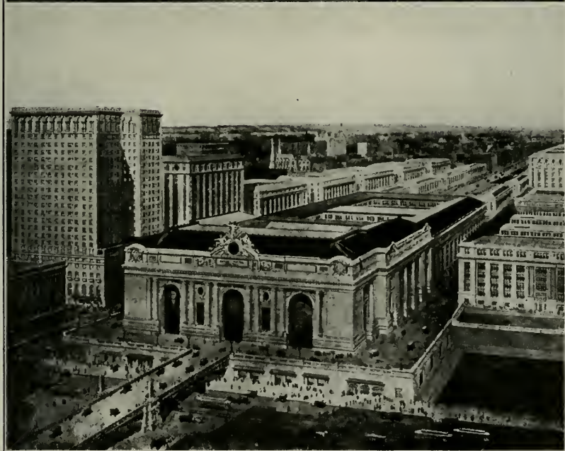
Fachada principal de la Estación Central y vista del mismo edificio a vuelo de pájaro.
