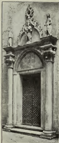
Porta laterale della chiesa delle Vigne.
