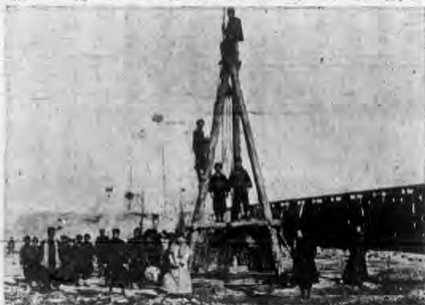
新樂橋上陸探鑽第二號橋墩地質時情形
