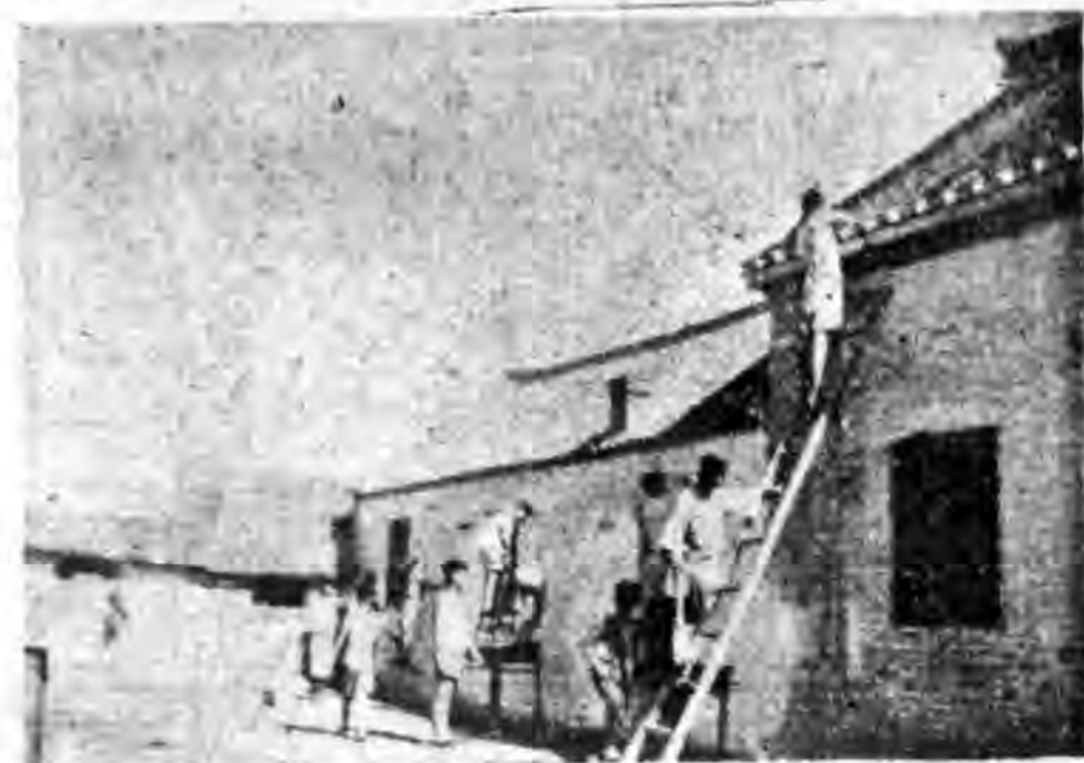
(六)小先生在粉刷牆壁及清理簷前滴水溝
