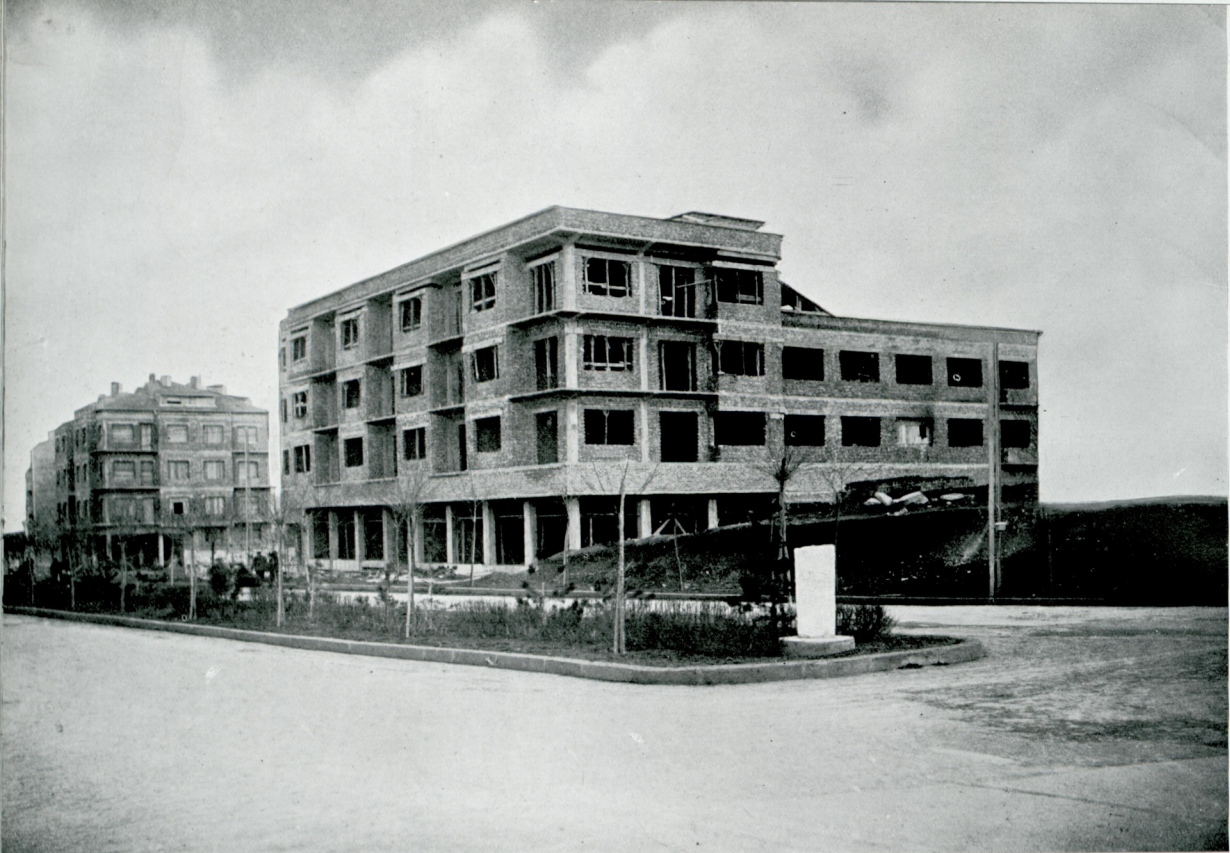
Nouvelles habitations en construction à Ankara.
