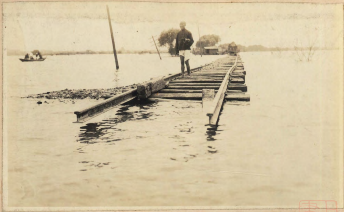
The Broken Railway Dyke at Tan Tung Men. 單洞門潰決鐵路
