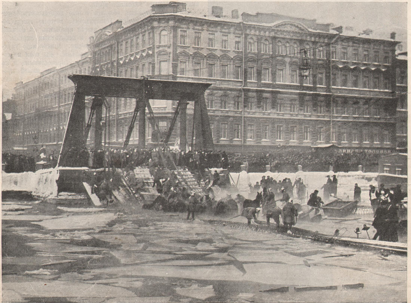
Проваль Египетскаго моста (черезъ р. Фонтанку) въ Петербургѣ, 20-го января с. г. По фот. К. Булла, авт. «Нивы».
