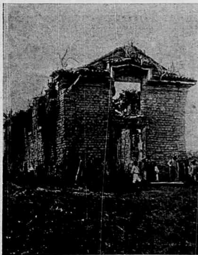
RUINAS DA EGREJA DO CARMO, CIDADE DE MATTO GROSSO, ONDE ESTÃO SEPULTADOS ADRIANO TAUNAY E O ENGENHEIRO ESPFRIDIÃO DA COSTA MARQUES.
