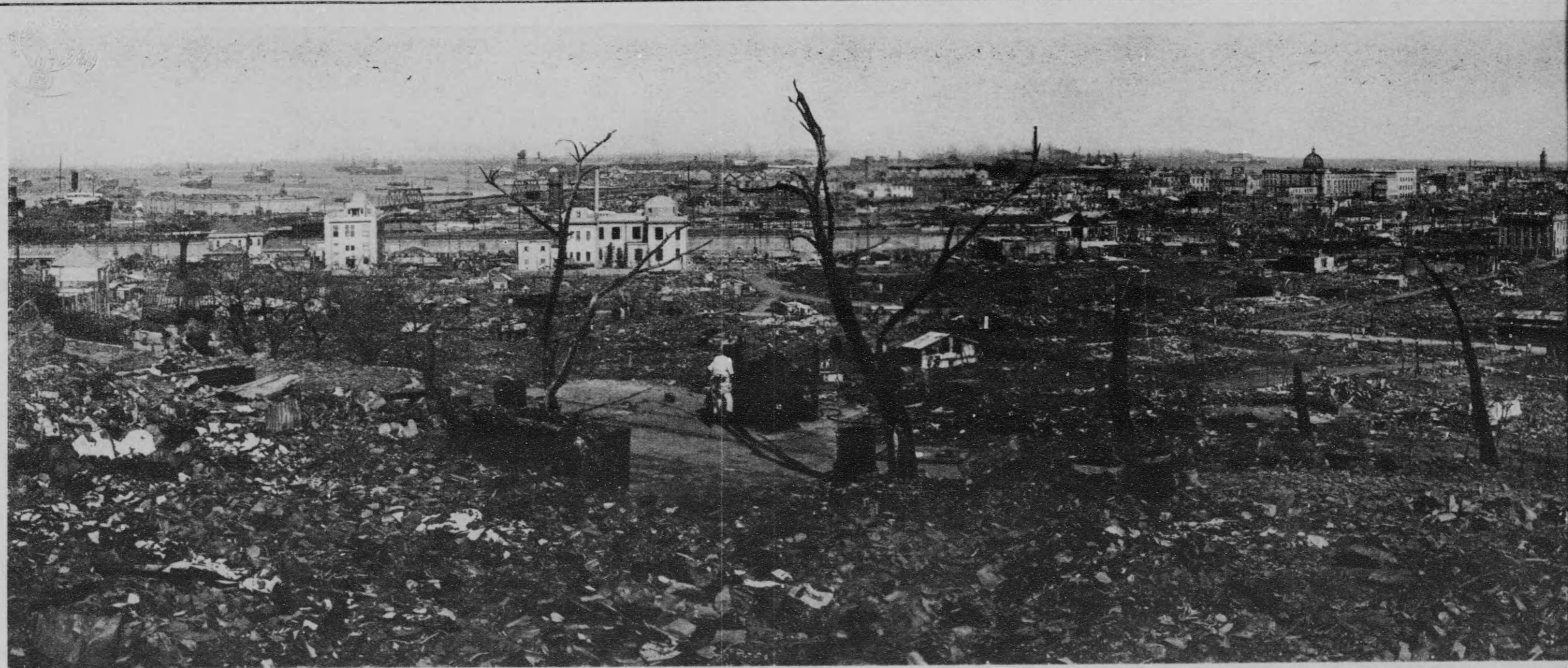
に沖し、石油は燃えつゝ海面に流出して大小のランチ、荷船等に延焼し、水陸俱に危険なる實に言語に絶した。かくて猛火は此市街に狂ふこと三日に亘り、全市殆ど全滅の慘禍を貽して鎮まつた。東京被服廠の大慘事にも比すべき正金銀行の悲惨事をはじめ、壓死者焼死者頗る多く、其總數は二萬三千と稱せられる。在住外人にも相當の犠牲者を生じた。著名な建造物で形骸を存して居るのは開港記念塔と正金銀行に過ぎない。
