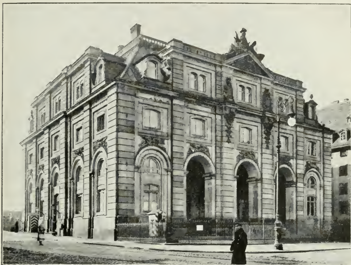
Abb. 88 Das Blockhaus nach dem Umbau von 1892
