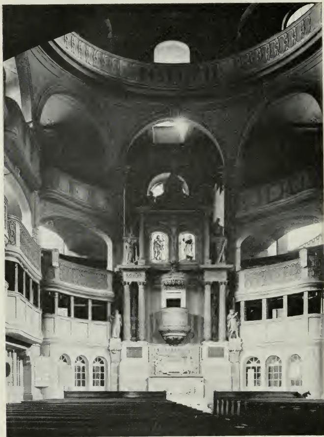
Abb. 108 Inneres der Annenkirche vor dem Umbau 1907
