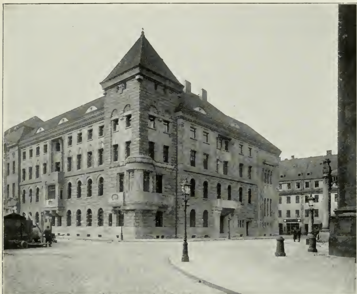
Abb. 164 Die Superintendentur von Schilling und Gräbner
