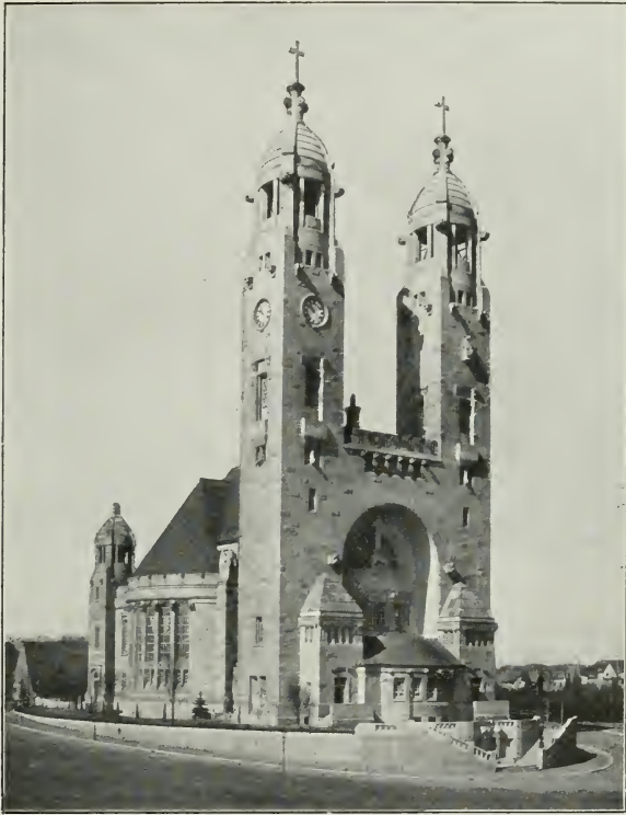
Abb. 148 Die Christuskirche in Vorstadt Strehlen von Schilling und Gräbner
