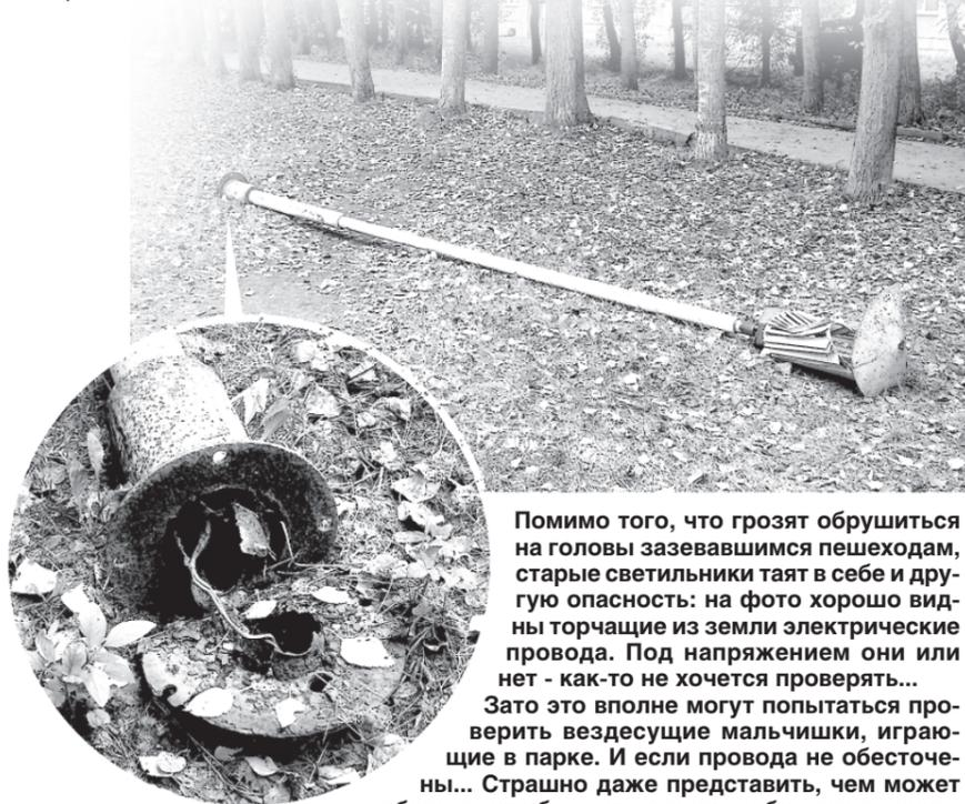
Помимо того, что грозят обрушиться на головы зазевавшимся пешеходам, старые светильники таят в себе и другую опасность: на фото хорошо видны торчащие из земли электрические провода. Под напряжением они или нет - как-то не хочется проверять... Зато это вполне могут попытаться проверить вездесущие мальчишки, играющие в парке. И если провода не обесточены... Страшно даже представить, чем может обернуться обычная детская любознательность.
