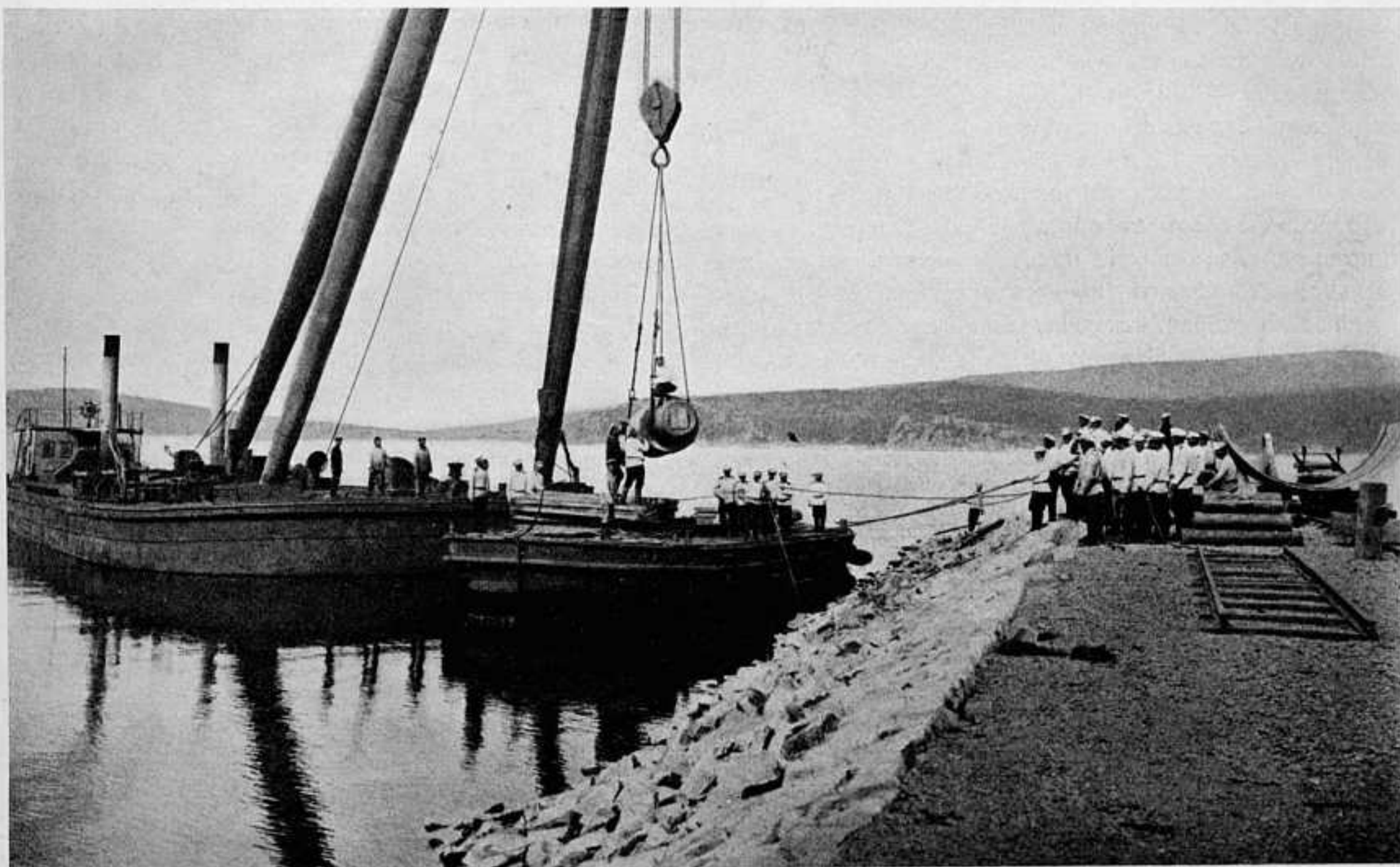
ВЛАДИВОСТОКЪ. РАБОТЫ ПО ВООРУЖЕНІЮ.
