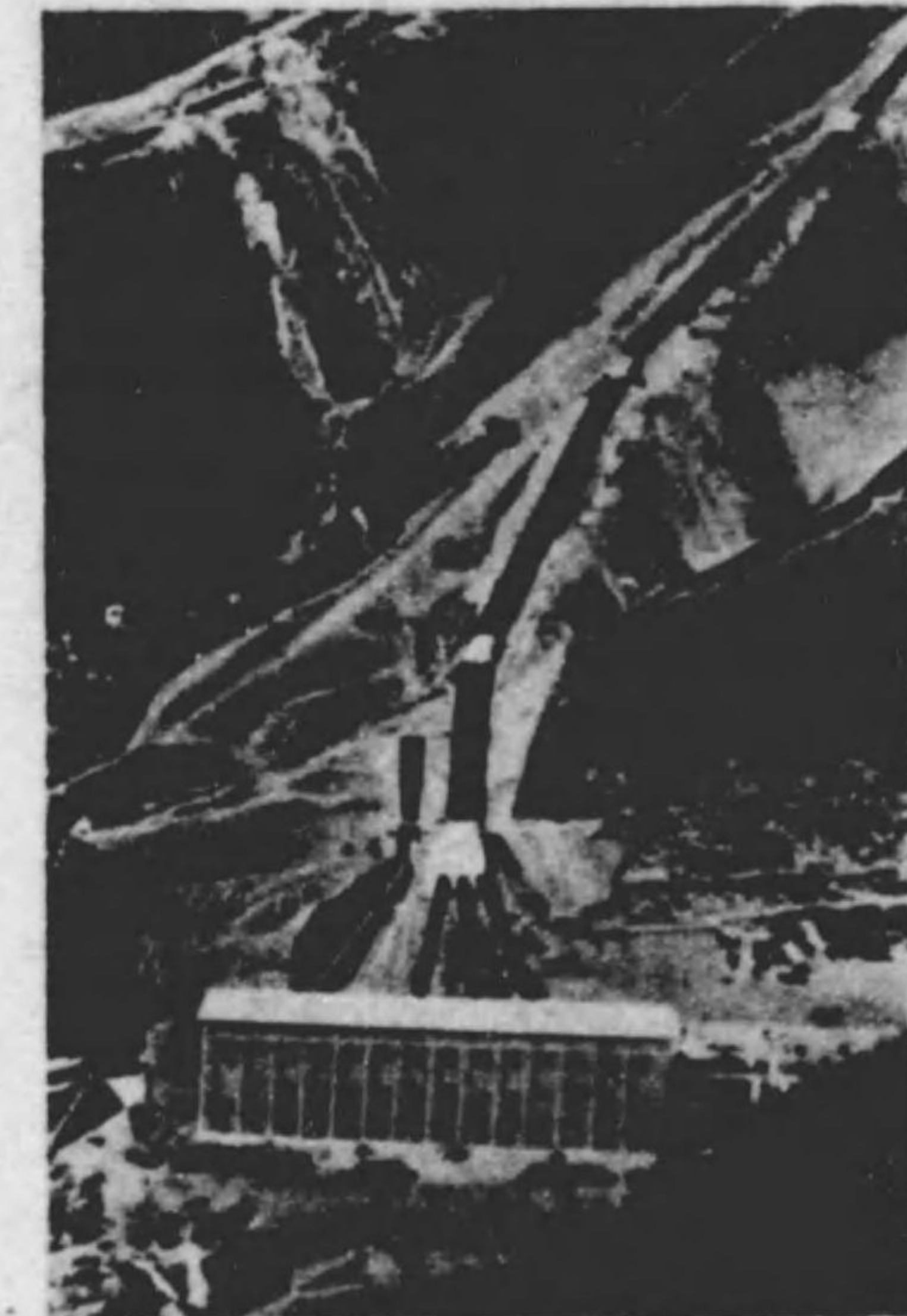
圖 134.4 發電所の全景
