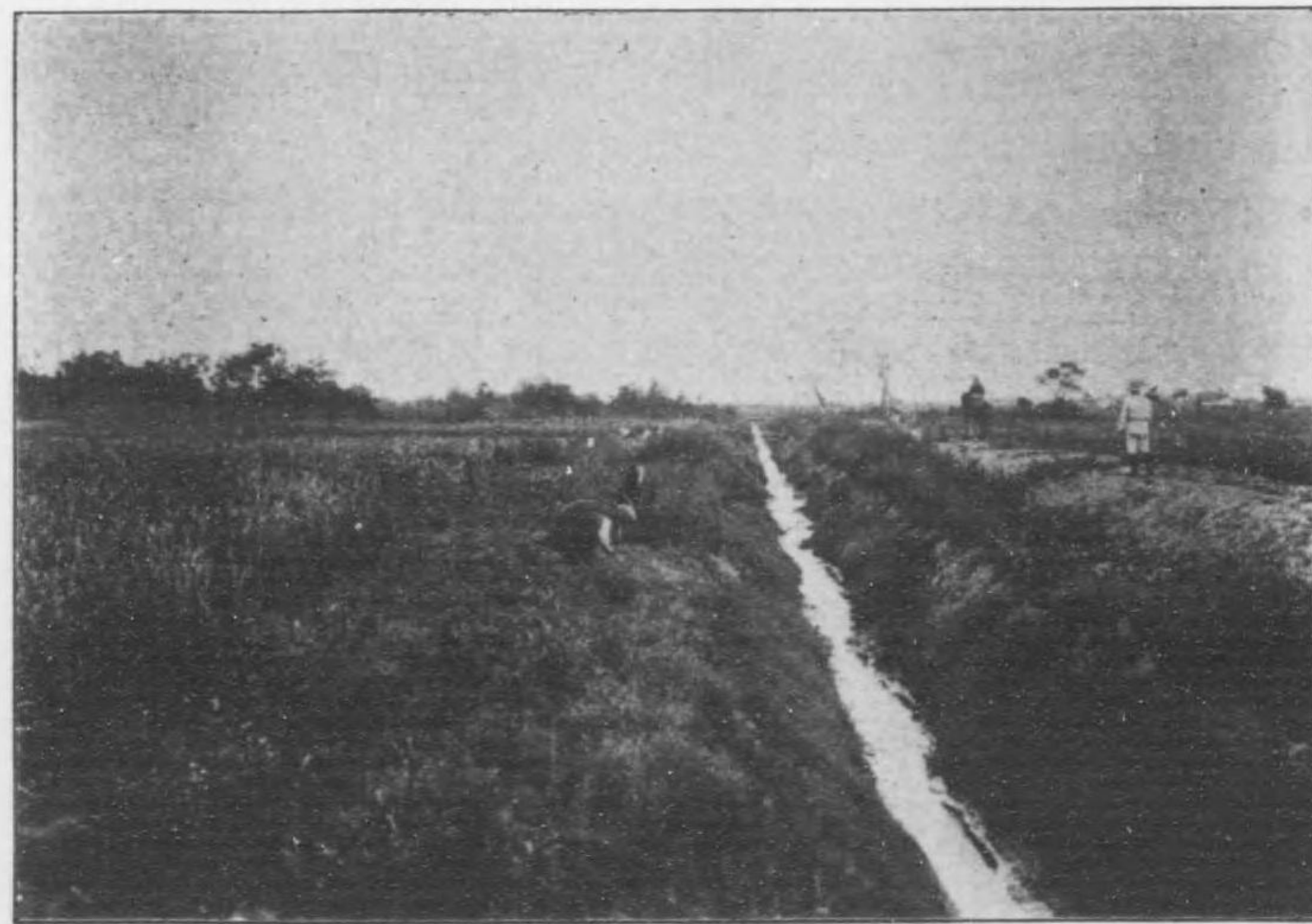
開墾地排水溝
