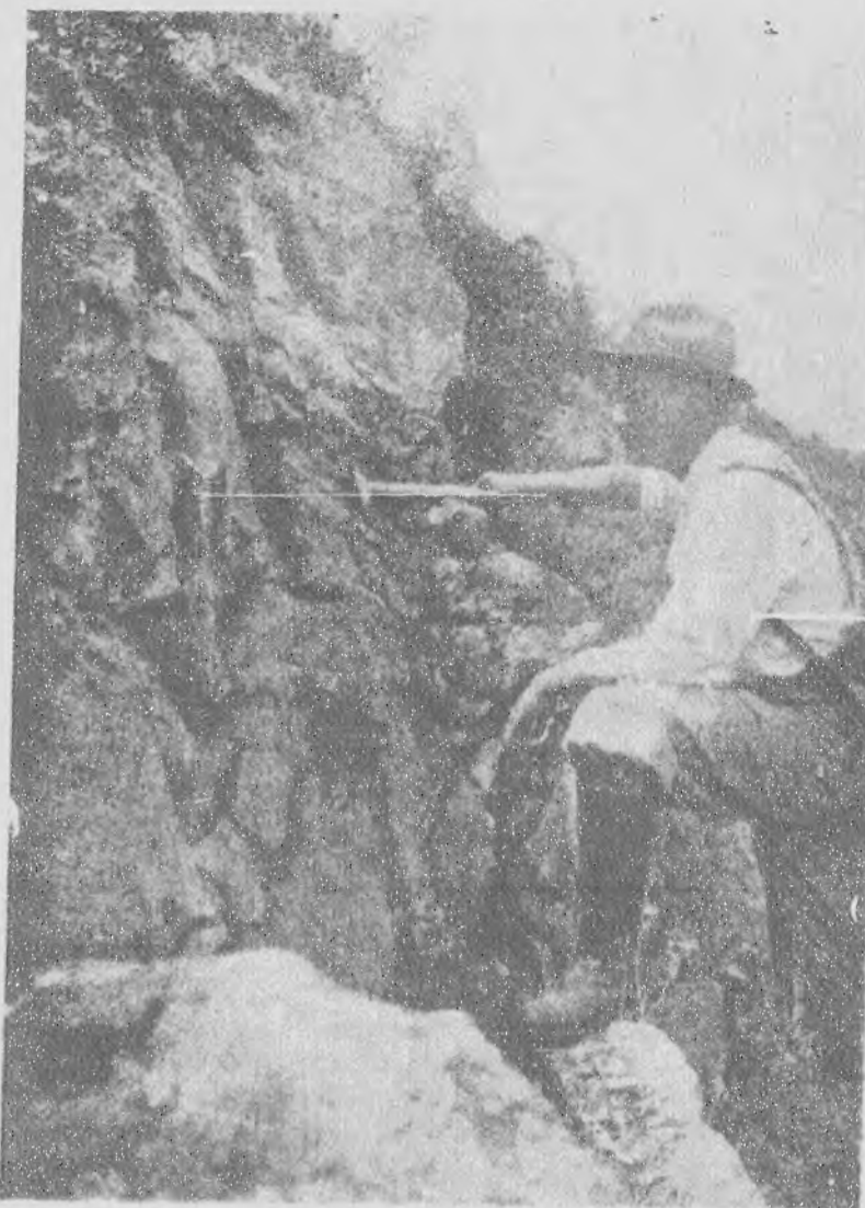
第一圖 船山西端出露之黃龍灰岩與船山灰岩之不整合接觸。
